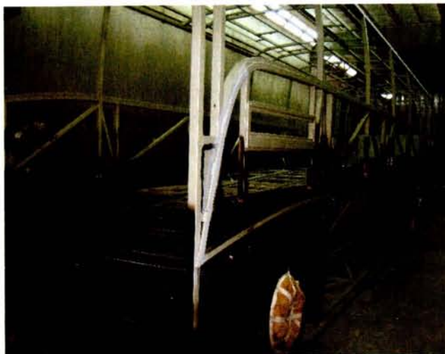
Figura 9 – Estrutura pintada e tratada na 1ª fase da Pintura
