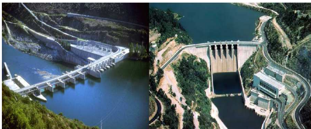
Figura 2.9 - Aproveitamento hidroeléctrico à fio-de-água (esq.) e albufeira (dir.).
