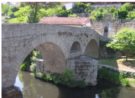
Figura 2.19 – Ponte Velha de Vizela – vista Montante.
