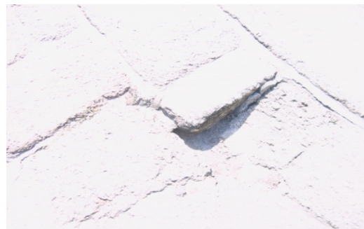
Figura 2.20 – Ponte de Velha vizela – Assentamento de Lajeado
