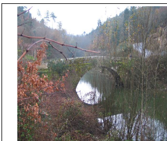
Figura 2.7 – Vista geral da ponte
