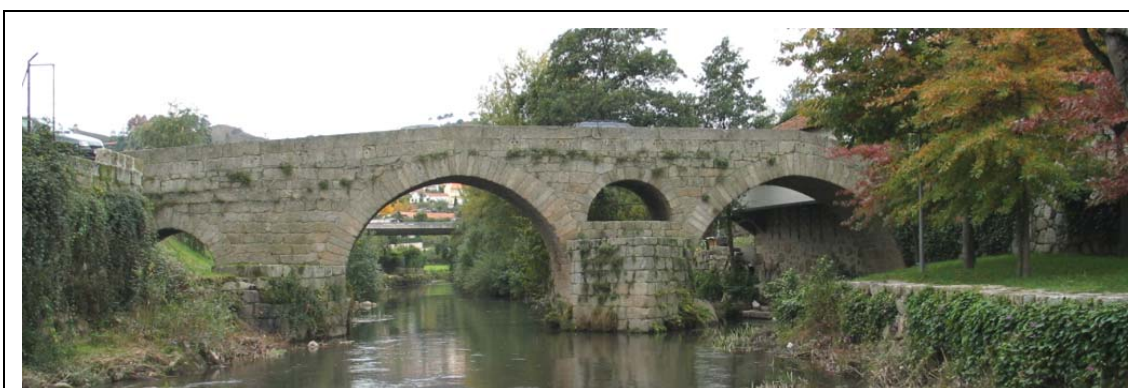
Figura 2.18 – Ponte Velha de Vizela – vista montante
