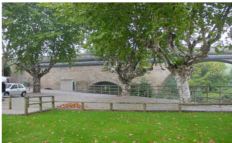
Figura 2.21 – Ponte de São Pedro do Sul – vista jusante
