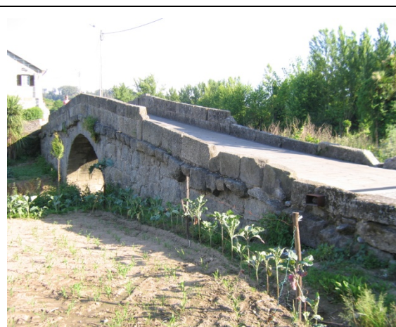
Fig. 2.12 – Ponte de Espindo 2009 – vista montante.
