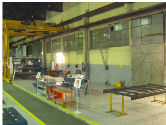
Figura 25 – Chão da zona de montagem depois ser pintado
