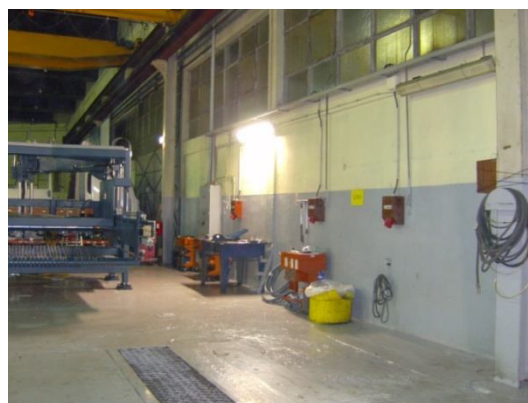
Figura 19 – Zona de montagem depois de estar limpa e arrumada
