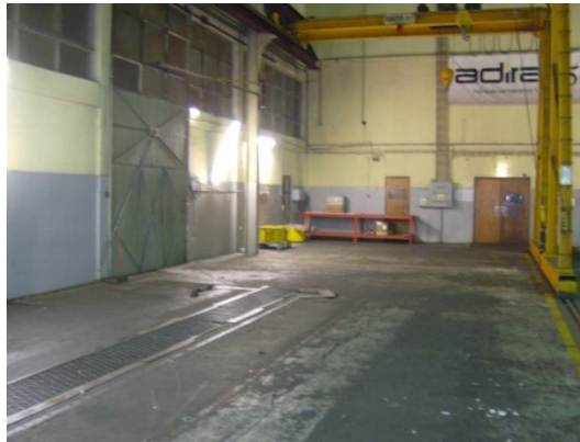
Figura 24 – Chão da zona de montagem antes de ser pintado
