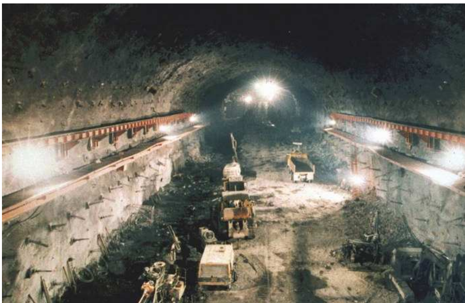
Fig. 3.5 – Vista da caverna de Mingtan, em fase de construção, através da ponte rolante provisória [29]
