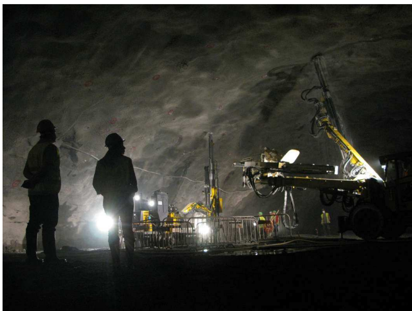
Fig. 5.3 – Fase de contenção, na escavação da abóbada da central do Picote (Cortesia de Patrícia Matos)
