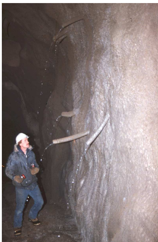
Fig. 5.11 – Sistema de drenagem no betão projectado [31]
