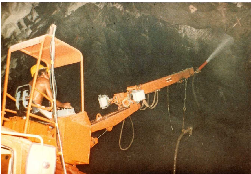
Fig. 5.10 – Aplicação de betão projectado [31]
