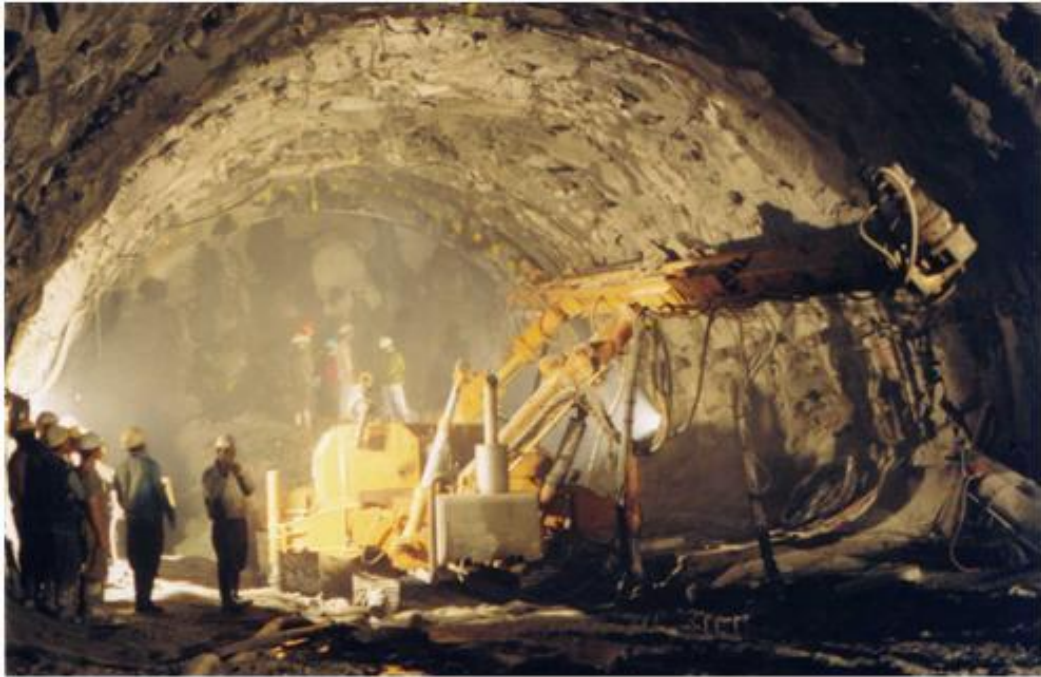
Figura 3. 8 – Instalação de enfilagens (Hoek , 2000)
