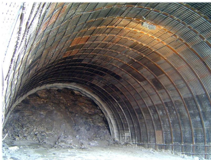
Figura 3. 5 – Cambotas HEB e chapas tipo Bernold no suporte de um túnel ( http://www.durofelguera.com/catalogo_tedesa )
