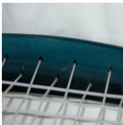
Figura 2.21: Diferente tipo de furação para a fixação das cordas ao aro.
