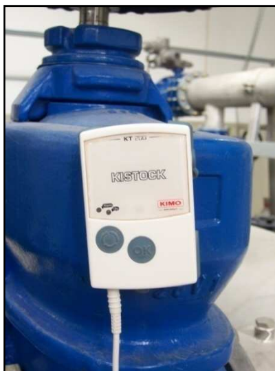
Figura 5.13 – Registadores Utilizados. Caso da Secção 2 – Registo da Pressão na Conduta de Compressão
