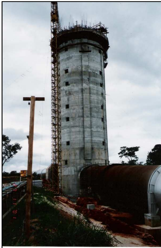
Figura 2.11 – Chaminé de equilíbrio em construção (Itiquira, Brasil)
