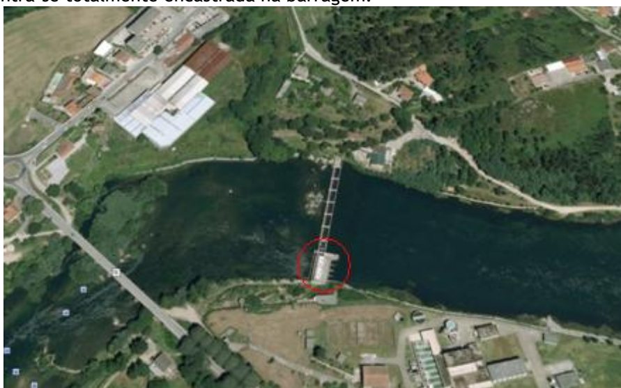
Figura 23 - Central Encastrada na Barragem.
