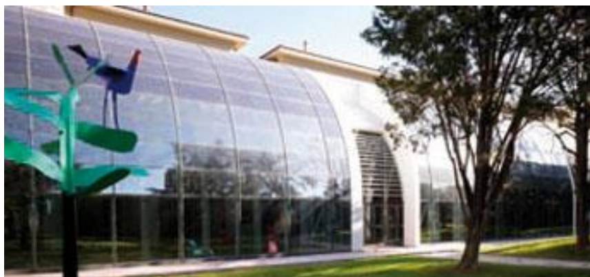
Figura 3.44 – Fachada do Hospital Meyer, Itália ( http://www.solon.com , 21/12/2009)
