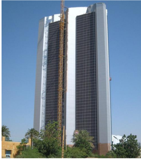
Figura 3.33 – Sede Nacional da Telecom Sudão ( http://www.sapa-solar.com , 18/12/2009)
