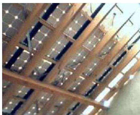
Figura 3.22 – Vista interior da cobertura de uma habitação em Surrey Hills ( http://www.pvsolar.com.au , 17/12/2009)
