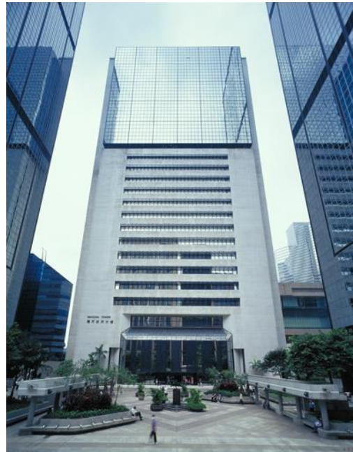
Figura 3.54 – Arranha-céus com fachada fotovoltaica em Hong Kong ( http://www.suntech-power.com/ , 22/12/2009)
