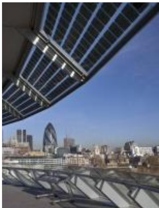
Figura 3.27 – Membrana de Sombreamento na ligação fachada cobertura da Câmara Municipal de Londres ( http://www.romag.co.uk , 17/12/2009)
