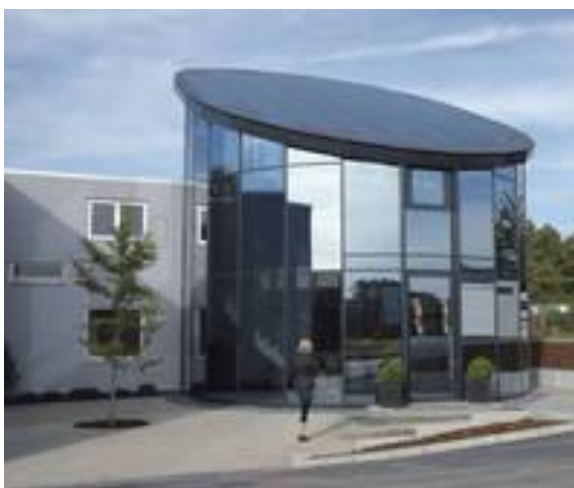
Figura 3.59 – Escritórios da firma Krall, Elsenfeld ( http://www.systaic.de , 23/12/2009)
