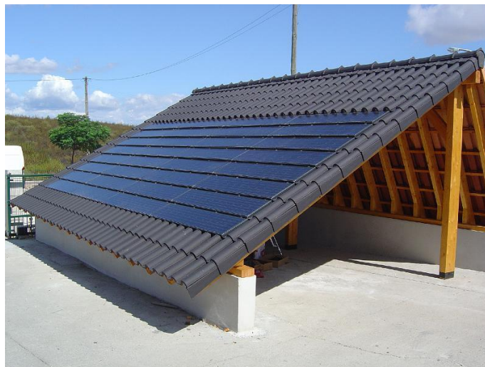
Figura 3.65 – Cobertura de demonstração para as telhas Solesia, na sede da empresa ( http://www.umbelino.pt , 26/12/2009)
