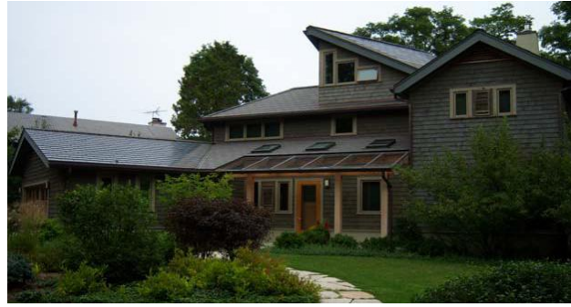
Figura 3.10 – Habitação Unifamiliar, Illinois ( http://www.atlantisenergy.com , 16/12/2009)
