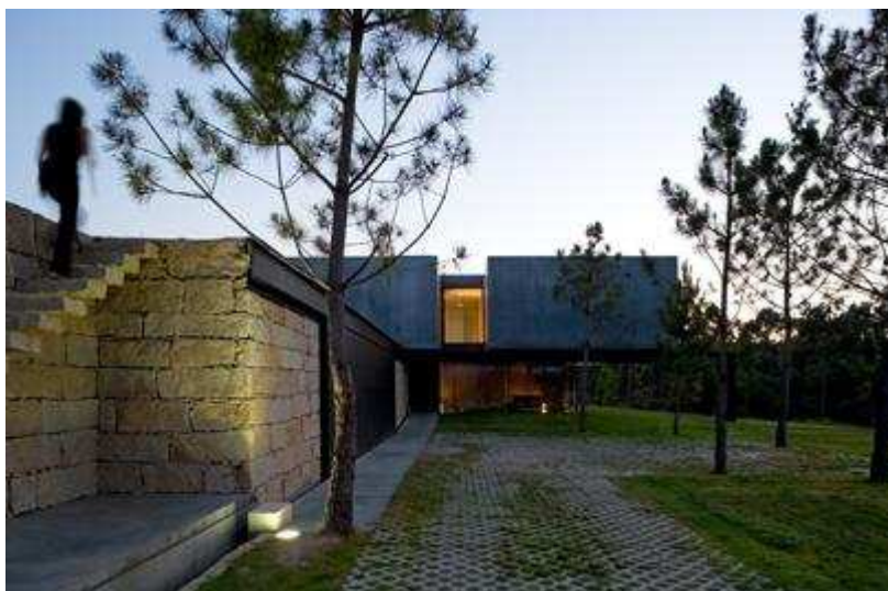
Fig.5.3 – Pormenor dos materiais utilizados
