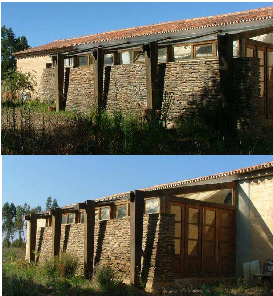
Fig.5.18 – Aspecto exterior da habitação
