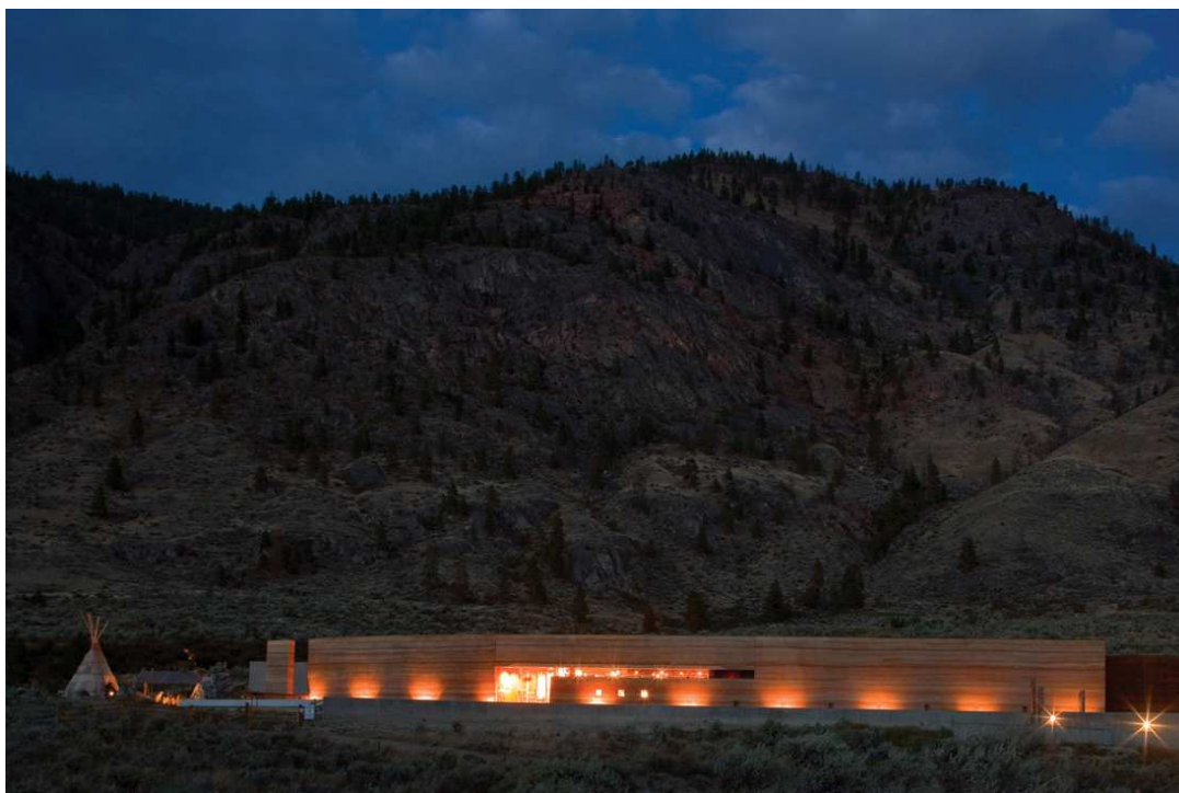
Fig.5.26 – Iluminação nocturna do centro
