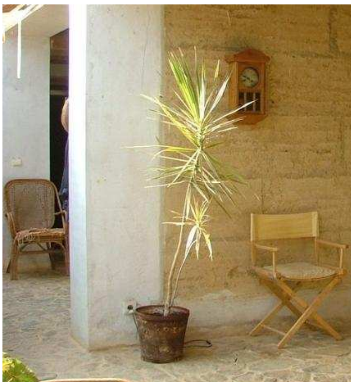
Fig.5.23 – Exemplo de um pilar em betão no interior da habitação
