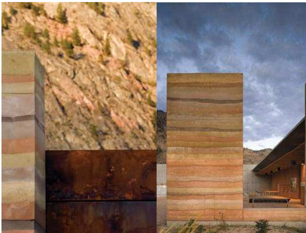
Fig.5.35 – Pormenor das camadas de terra do muro
