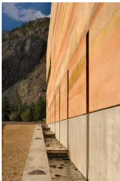
Fig.5.34 – Canal na base do muro de terra
