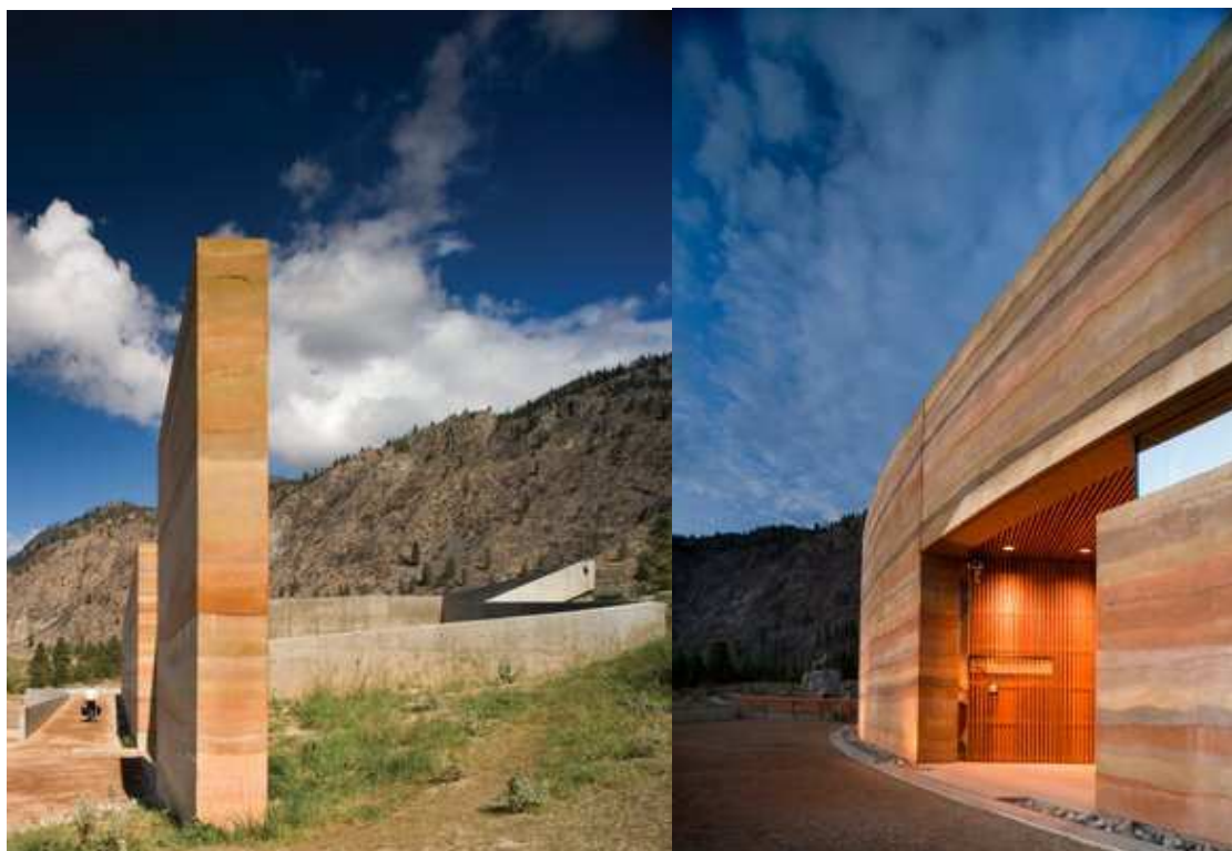
Fig.5.33 – Muro de terra
