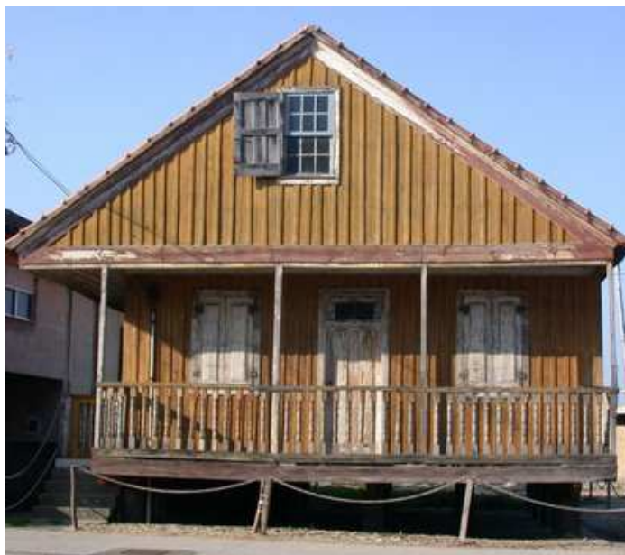
Fig.2.5 – Casa de Madeira
