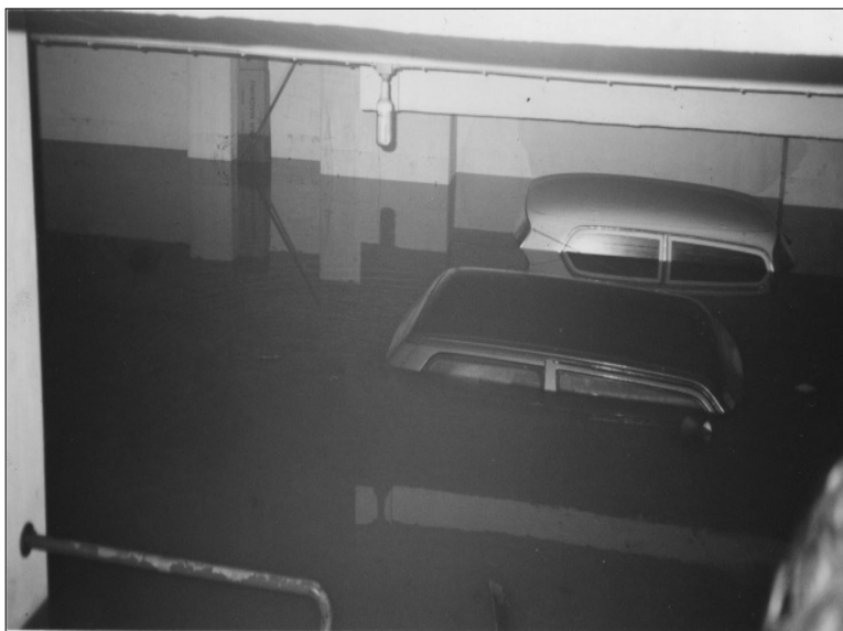
Figura 54– Vista do interior da garagem de um Bloco habitacional da Rua Ferreira de Castro no dia 21 de Março de 2001. (Alexandre Peralta)
