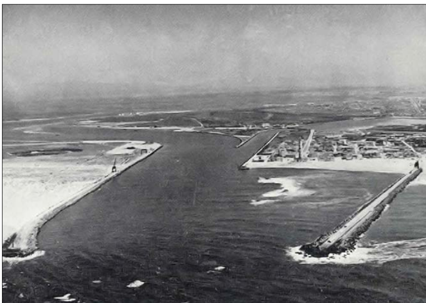
Figura 61 – Construção dos molhes da barra 1936 (Biblioteca Municipal de Ovar)
