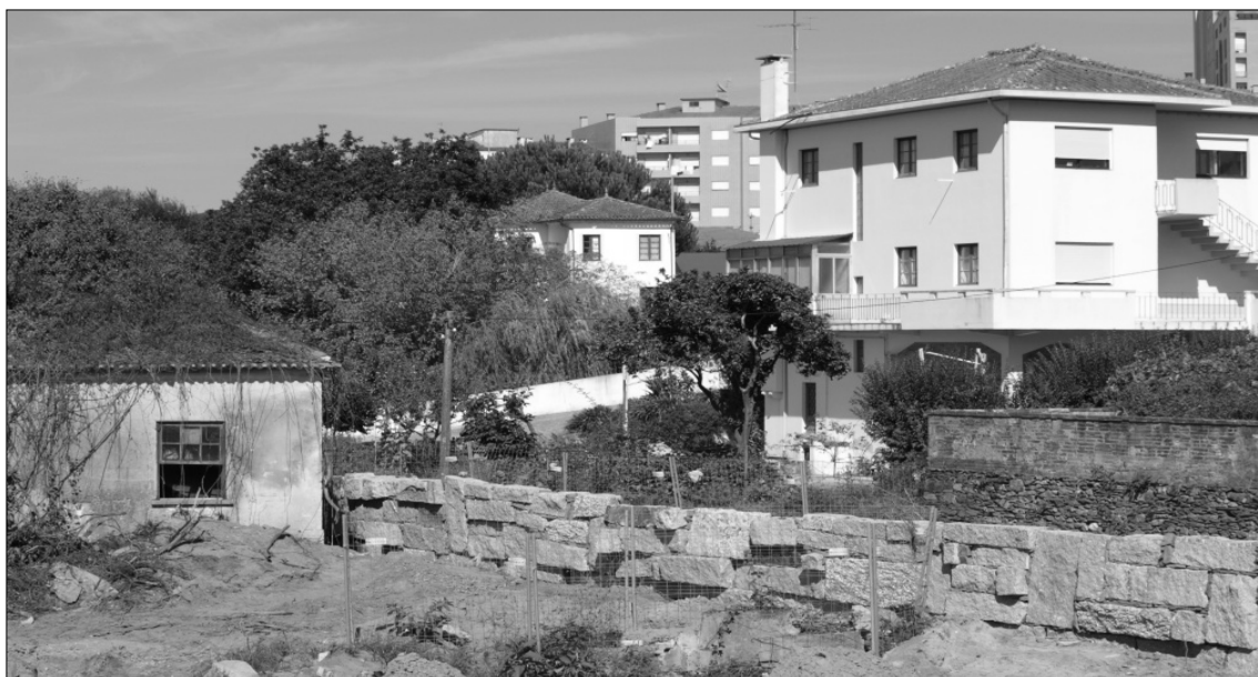
Figura 77 – Vista da estrutura de protecção do edificado interior da margem nascente do Rio Cáster (2011).
