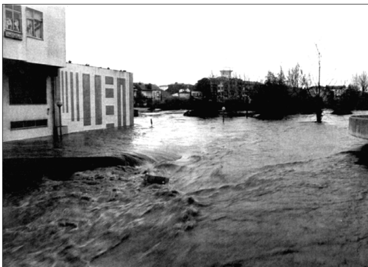
Figura 53 – Vista do acesso às garagens de um Bloco habitacional da Rua Ferreira de Castro no dia 21 de Março de 2001. (Arquivo do autor)
