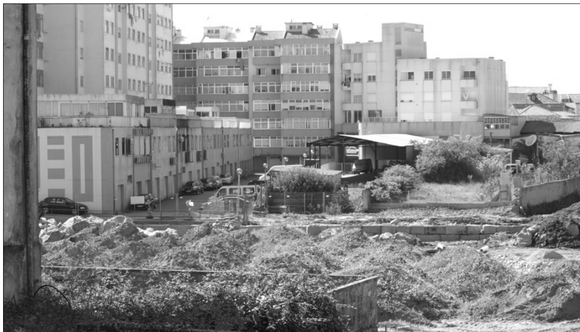
Figura 76 – Vista da estrutura de protecção da margem poente do Rio Cáster, Setembro 2011
