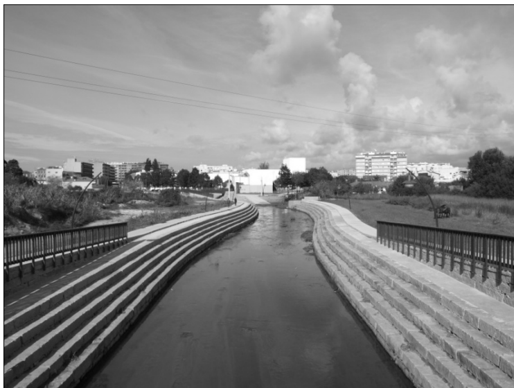
Figura 74 – Vista parcial das obras de regularização das margens do Rio Cáster na envolvente a Rua Elias Garcia, Maio 2010.
