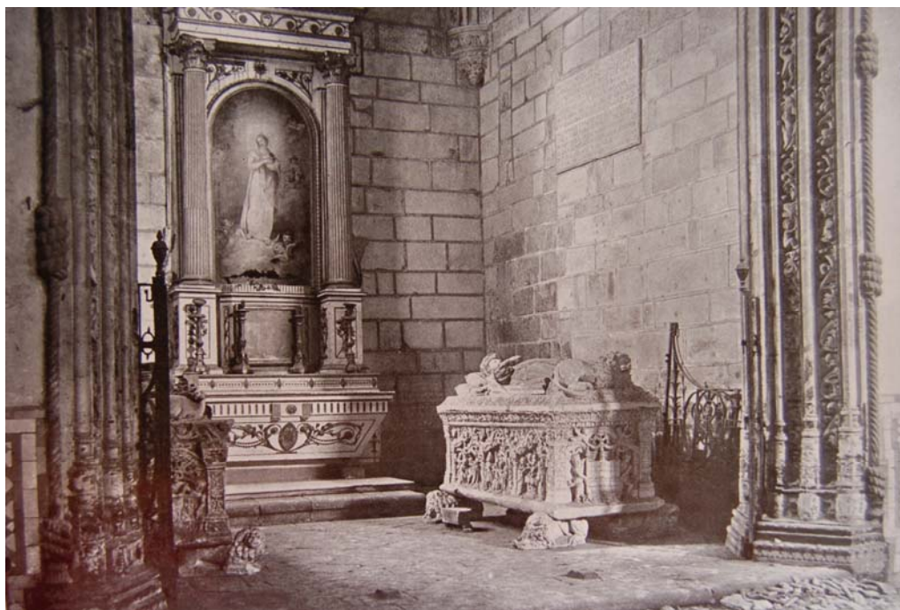
Imagem 91: Vila do Conde – A “Capela dos Fundadores” antes de obras de limpeza 91 .
