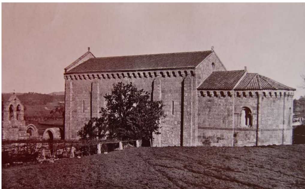
Imagem 84: O mesmo aspecto, depois de terminados os trabalhos 84 .
