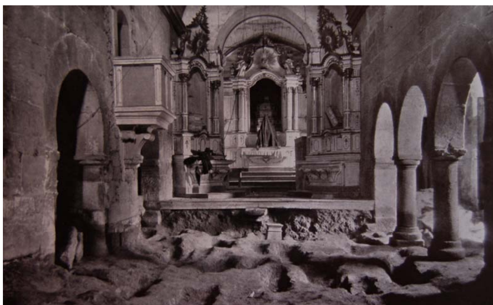
Imagem 103: Igreja Matriz de Lourosa – Oliveira do Hospital – A nave central durante os trabalhos 103 .
