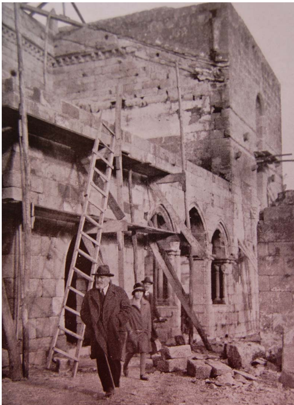
Imagem 67: Vila do Conde – O sr. dr. Alfredo de Magalhães observando as obras de restauração da igreja de Santa Clara 67 .
