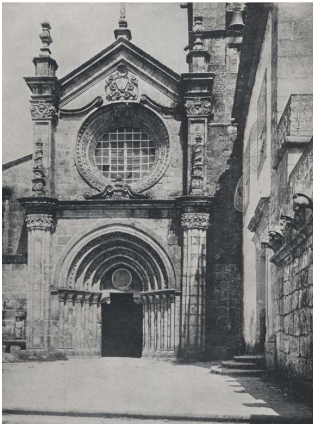
Imagem 22: Igreja de Paço de Souza (Concelho de Penafiel) – Fachada 22 .
