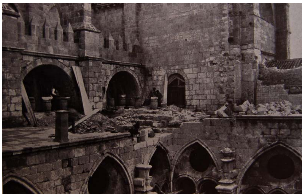
Imagem 96: Sé Catedral do Porto – O mesmo aspecto durante as obras” 96 .
