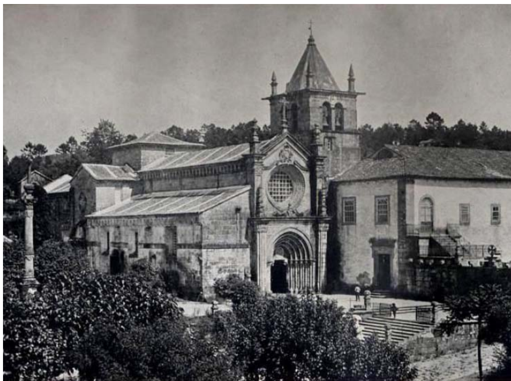
Imagem 23: Igreja de Paço de Souza (Concelho de Penafiel) – Exterior 23 .
