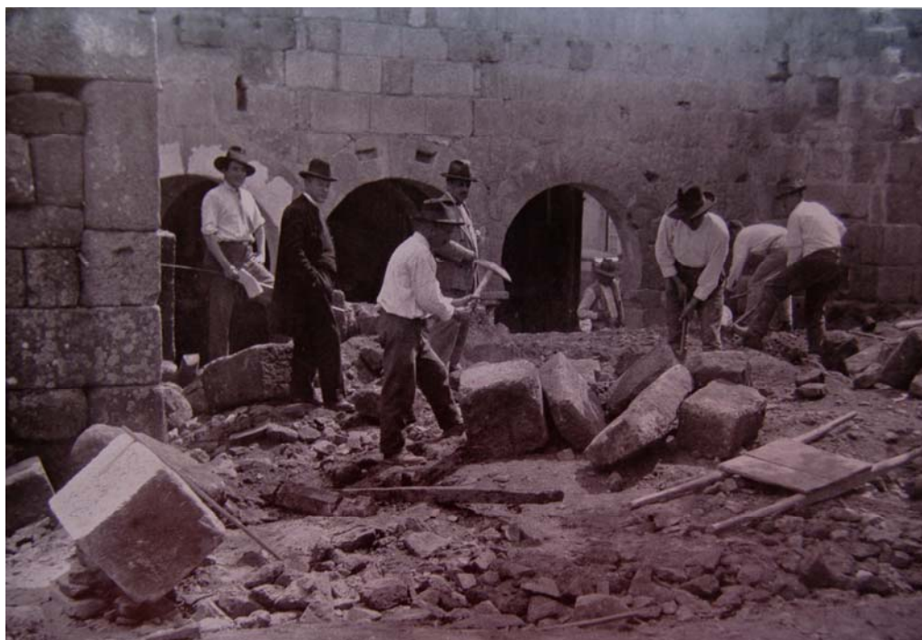
Imagem 69: Igreja de Lourosa – Mãos à obra – Os srs cónego Aguiar Barreiros e José Villaça continuam os seus estudos mesmo depois de iniciados os trabalhos de restauração 69 .
