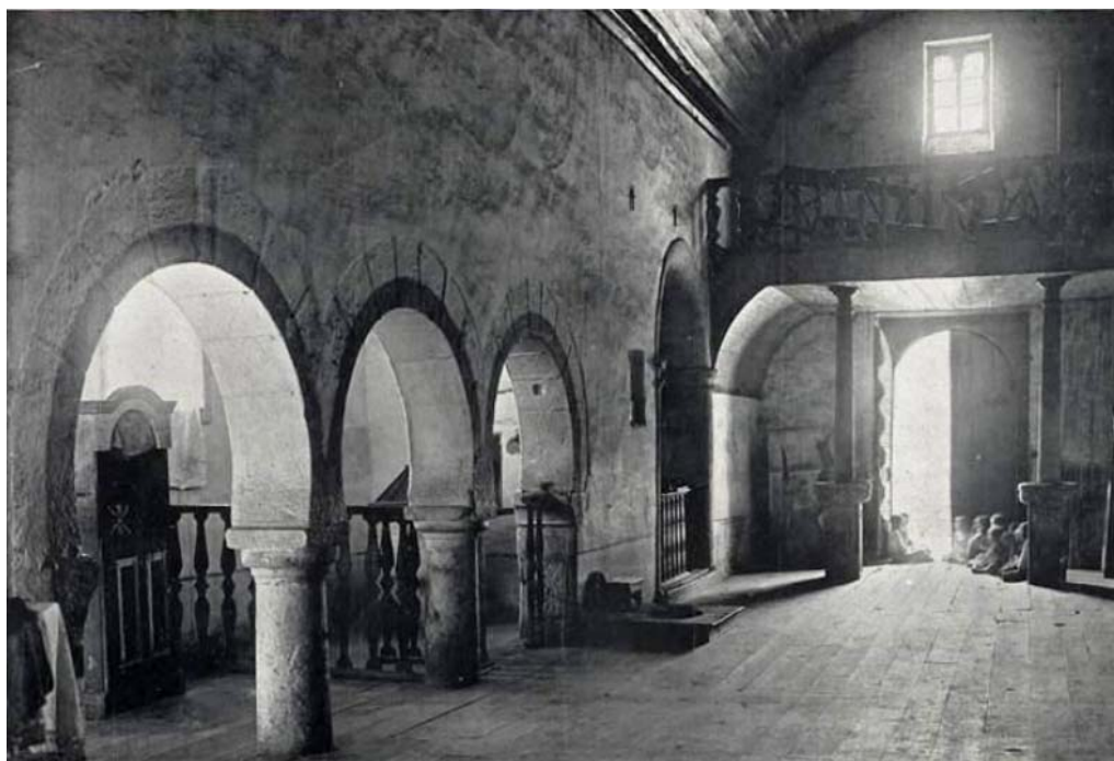
Imagem 18: Igreja da Lourosa (Concelho de Oliveira do Hospital) – Interior; Nave central com entrada principal 18 .
