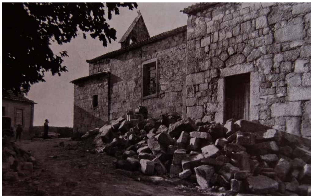
Imagem 102: Igreja Matriz de Lourosa – Oliveira do Hospital – Topo do transepto Sul durante as obras 102 .
