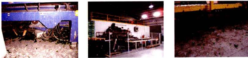
Figura 22 - Estado inicial da zona de embalagem
