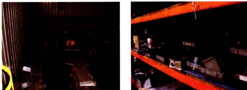
Figura 30 -Estado inicial do interior do armazém de manutenção
