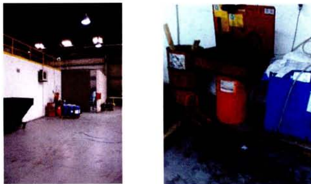
Figura 25 - Estado final das traseiras do armazém de manutenção
