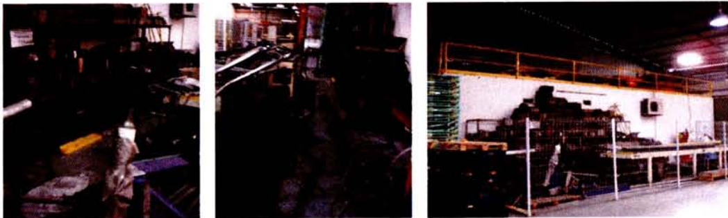
Figura 24-Estado inicial do armazém da manutenção
