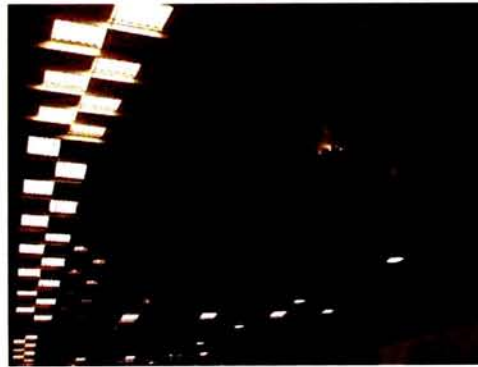
Figura 48-Iluminação da zona de embalagem do AV5
