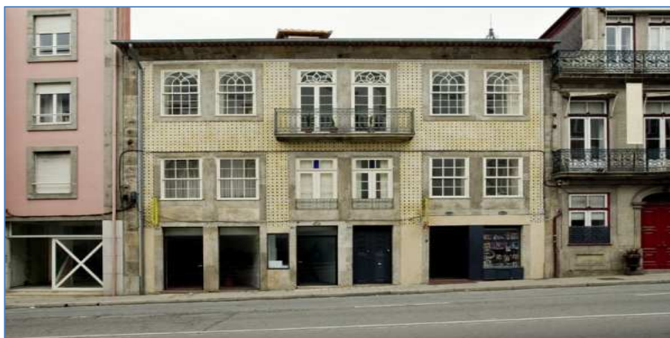
Fig. 13 - Prédio sito na Rua D. Manuel II n.º 170 no Porto 100
