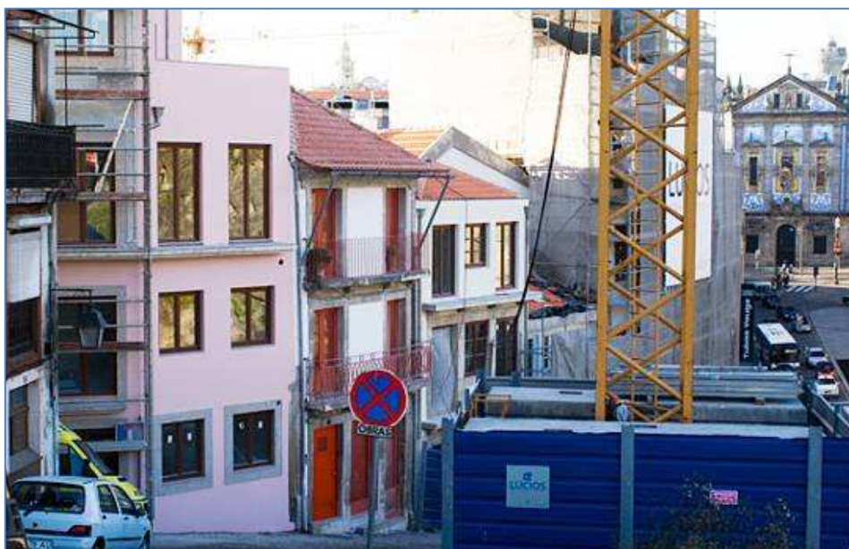
Fig. 28 - Instalações da futura residência universitária no Morro da Sé
