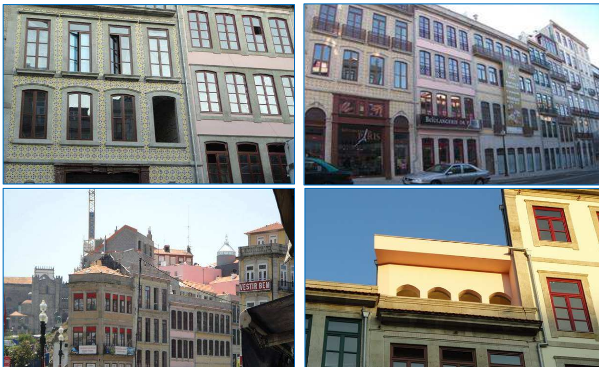
Fig. 31 a), 31 b), 31 c) e 31 d) - Vistas do quarteirão do Corpo da Guarda 161
