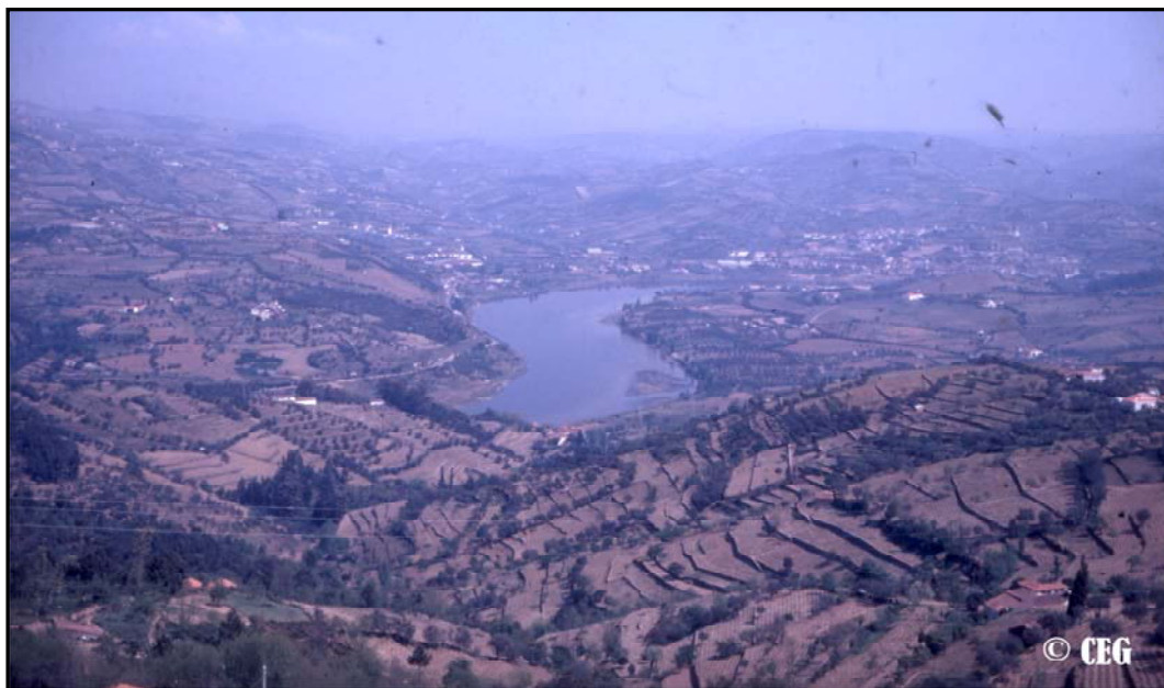
Fig. 39 – Vista da Régua, tirada da pousada da margem esquerda do Douro a jusante de Lamego.
