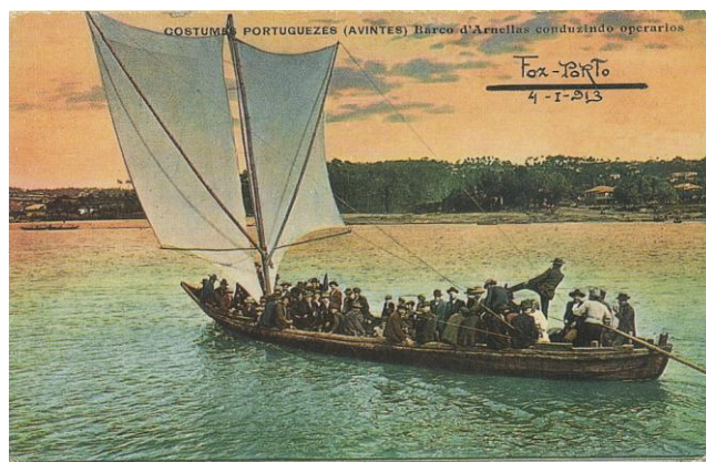
Figura n.º 24 – Avintes – Barco conduzindo operários – 1913
