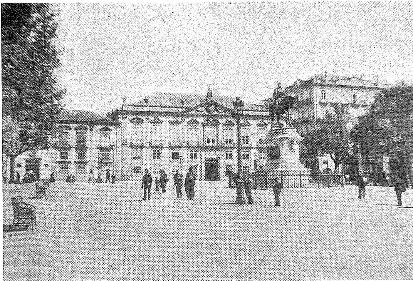
PRAÇA COM ESTÁTUA E PRÉDIOS DA CÂMARA
