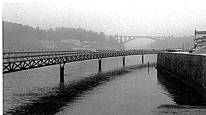
O VIADUTO DO CAIS DAS PEDRAS
