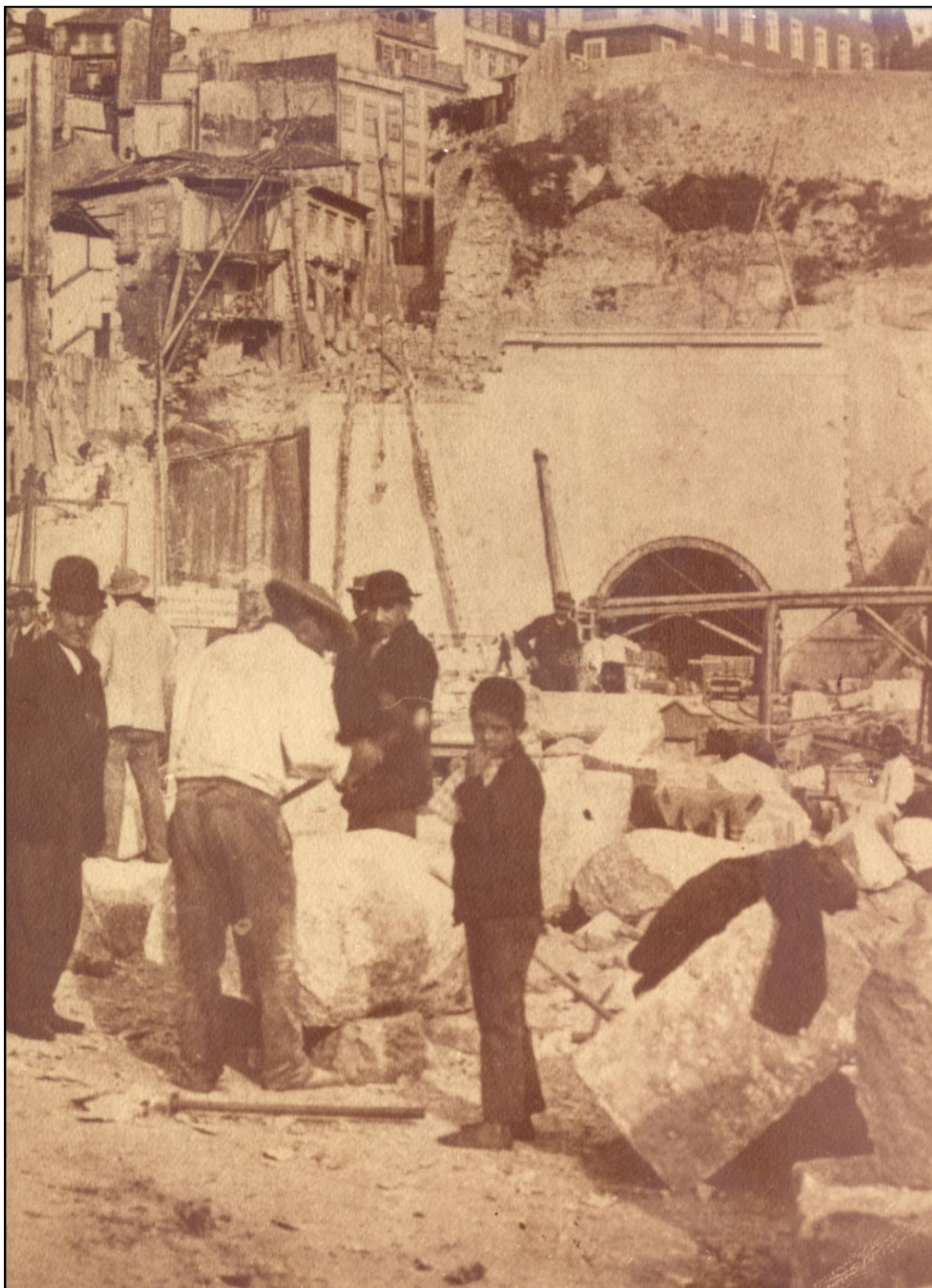
Ilustração 16 - Trabalhos no Túnel
