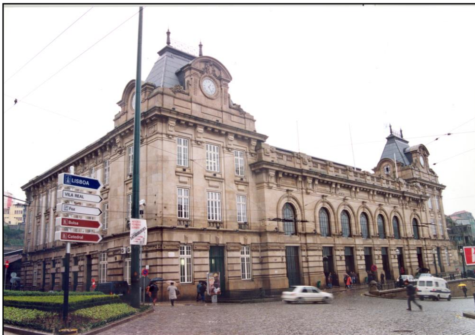
Ilustração 12 – Estação de S. Bento fachada actual
