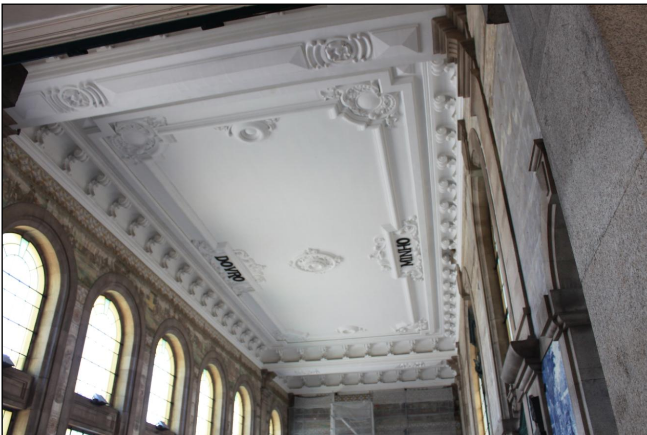
Ilustração 22 - Pormenor do tecto vestibulo da Estação de S. Bento
