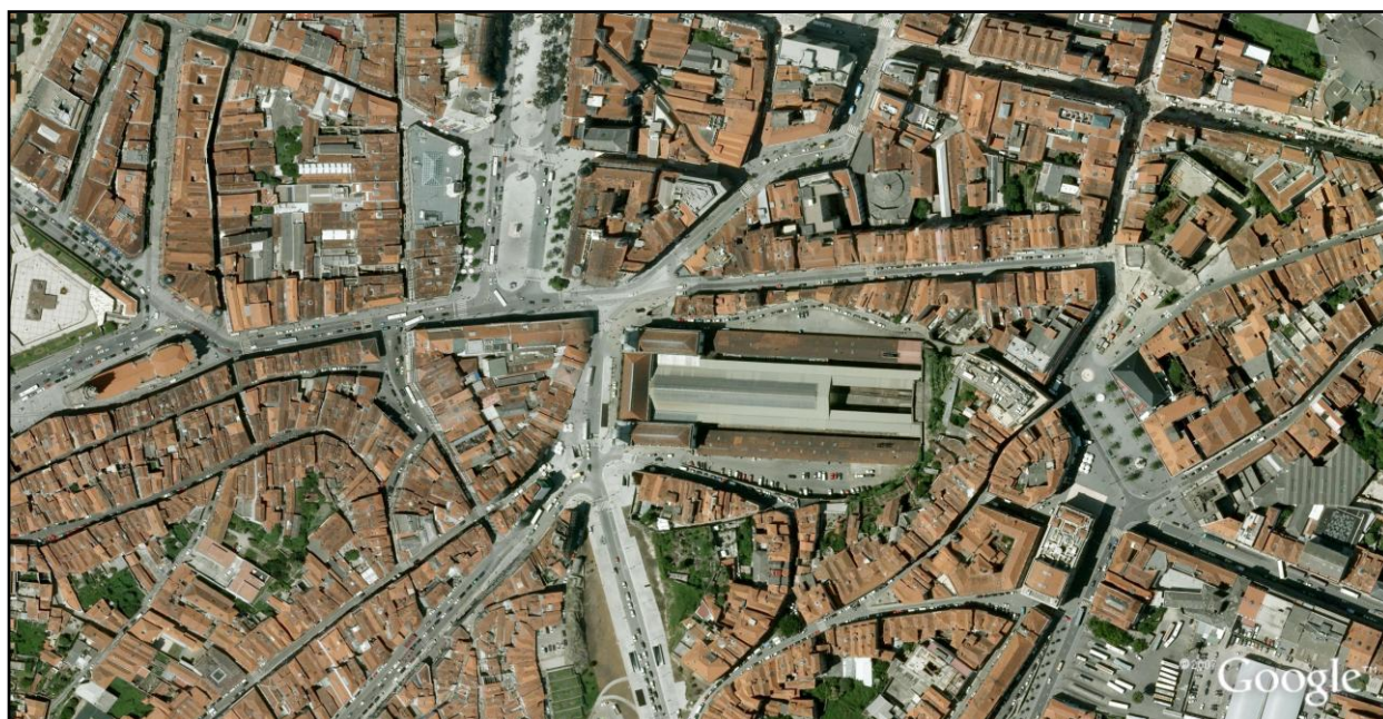
Ilustração 9 - Estação de S- Bento vista área
