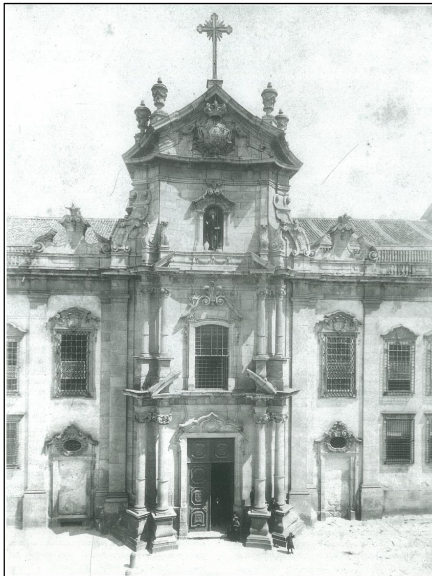
fig. 4 – Pormenor do portal de entrada da Igreja
