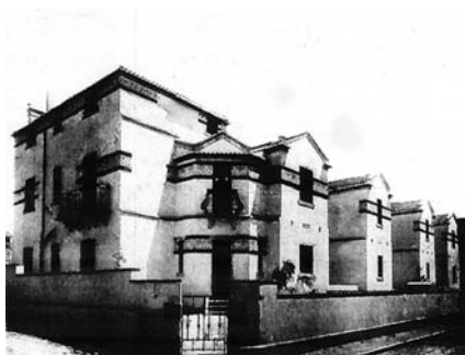
Bairro das Roseiras, fachada principal, Álvaro Machado, 1910
