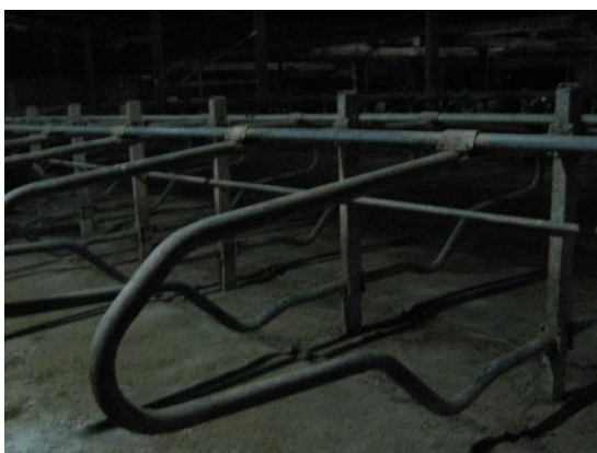
Figura 13 Barra limitadora colocada a menos de 1m de altura desde o cubículo
