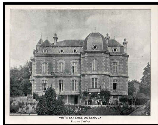
Fig. 10: Vista lateral da Escola (rua de Camões).
