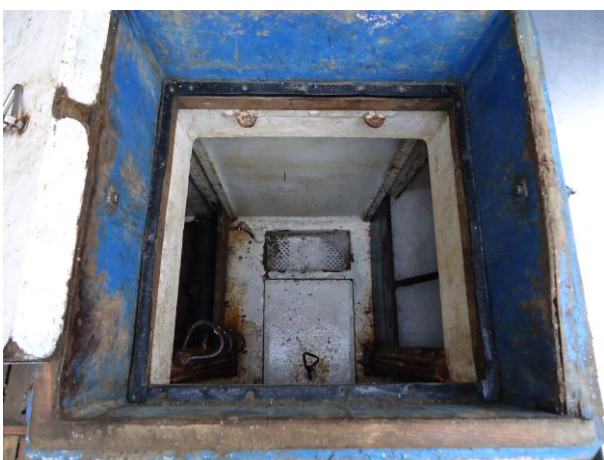
Figura 6 – Porão de armazenamento de pescado em avançado estado de degradação.
