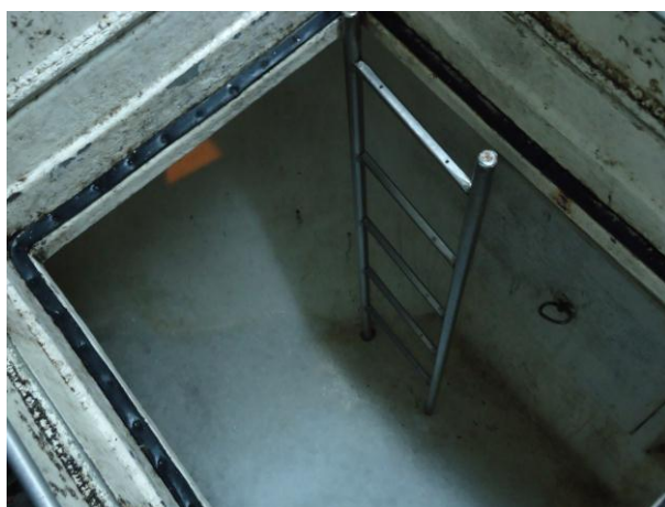
Figura 7 – Porão de acondicionamento de pescado.
