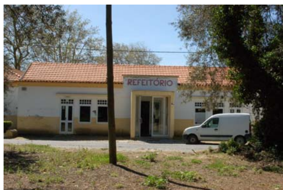
Refeitório actual da Vista Alegre
