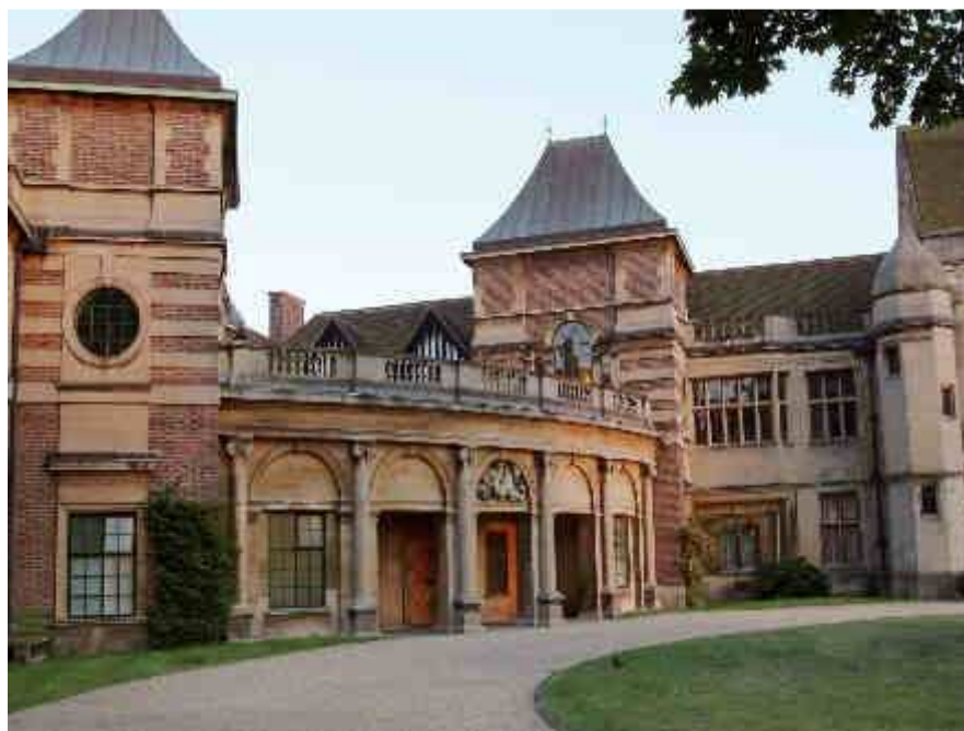
Figura A.12. – Fachada de Eltham Palace (Norte) 6
