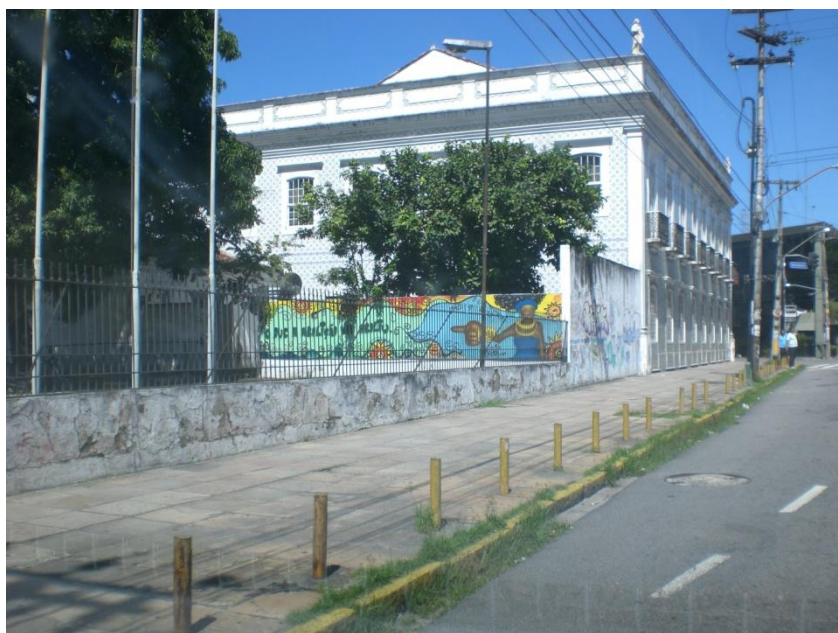
Foto 23: Casa-grande do Engenho da Madalena. Autor: Mércia Carréra.
