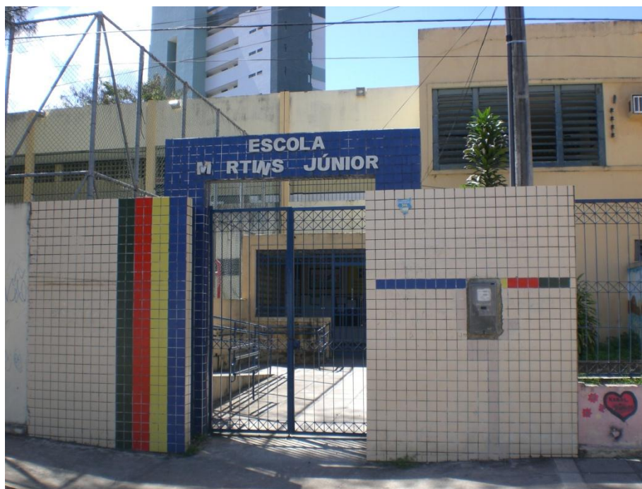
Foto 24: Local da antiga Casa-grande do Engenho da Torre, atualmente Escola Martins Junior. Autor: Mércia Carréra.
