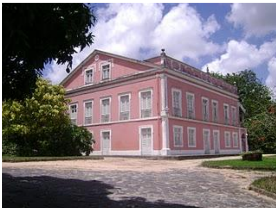
Foto 15: Casa-grande do Engenho Camaragibe. Autor: Mércia Carréra.
