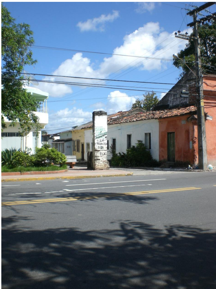
Foto 28: Ruína do antigo Engenho São Pantaleão do Monteiro. Autor: Mércia Carréra.
