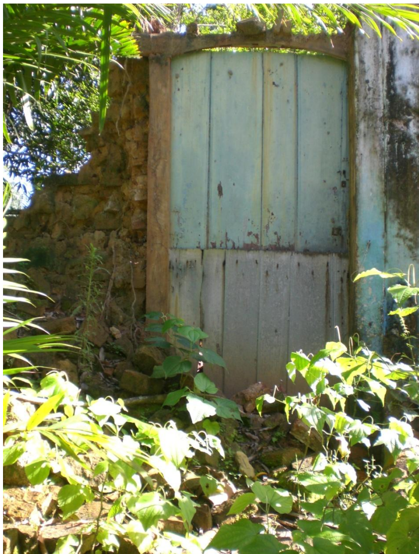
Foto 21: Ruínas da Casa-grande do Engenho Jaguaribe. Autor: Mércia Carréra.
