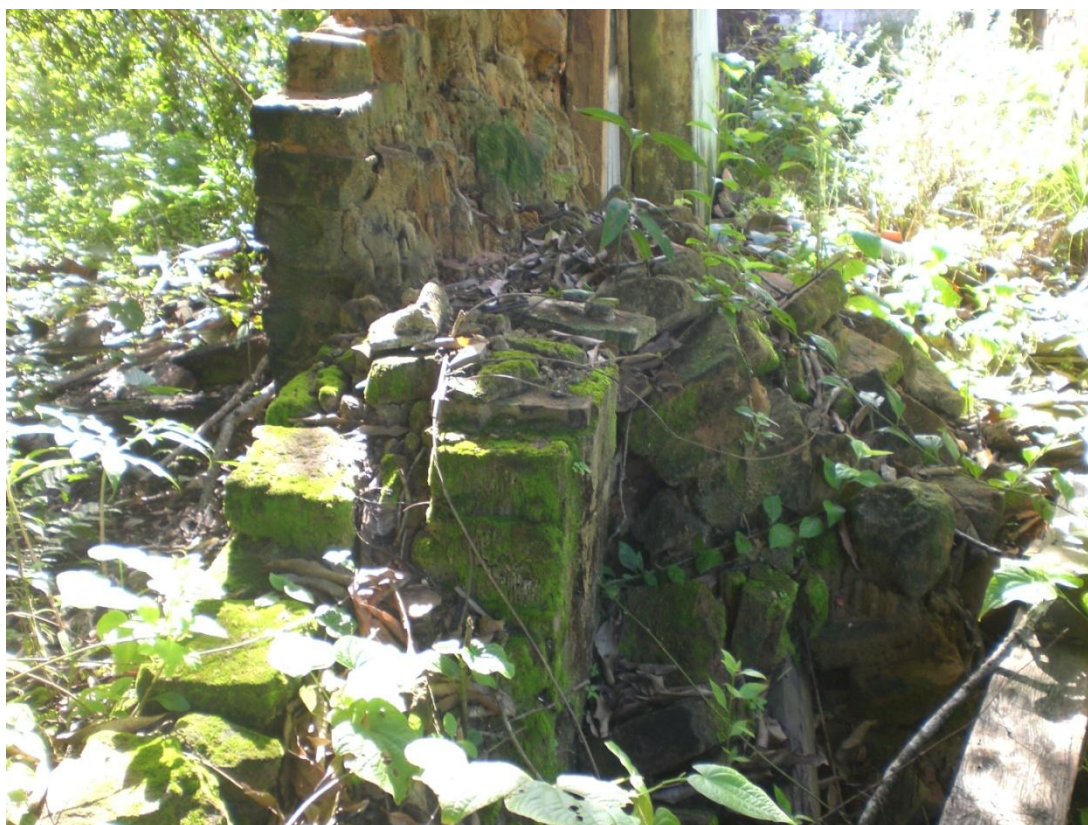
Foto 19: Ruínas da Casa-grande do Engenho Jaguaribe. Autor: Mércia Carréra.
