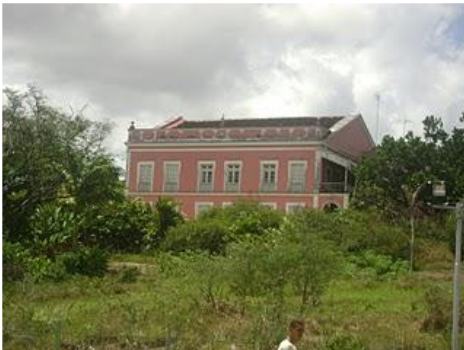
Foto 16: Casa-grande do Engenho Camaragibe. Autor: Mércia Carréra.
