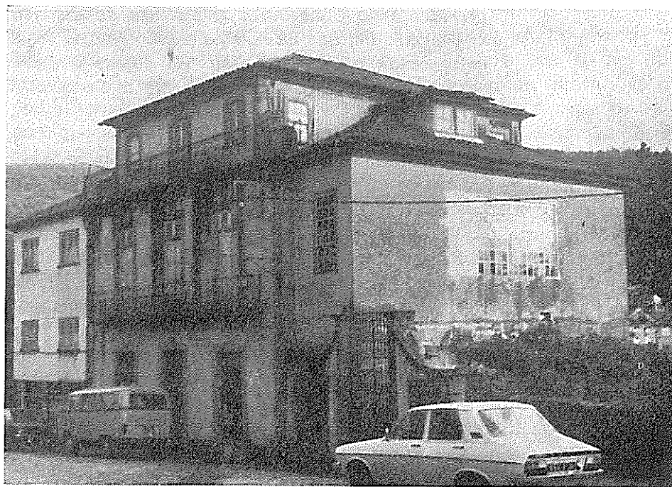
Casa do Dr. Passos, construída com pedras da muralha
