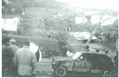
Foto 5 | Área afectada pelo fluxo de detritos de Ariz (Régua, 2002)
