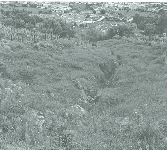
Fig. 15 | Cicatriz do fluxo de detritos de Ariz vista de montante para jusante
