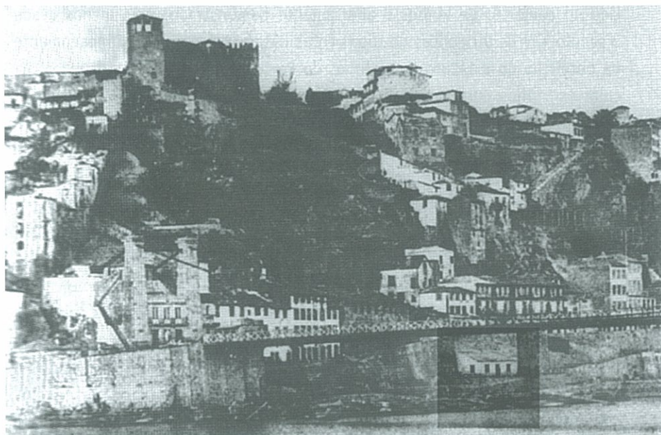
Foto 1 | Posto de controlo dos barcos do Douro junto aos Guindais
