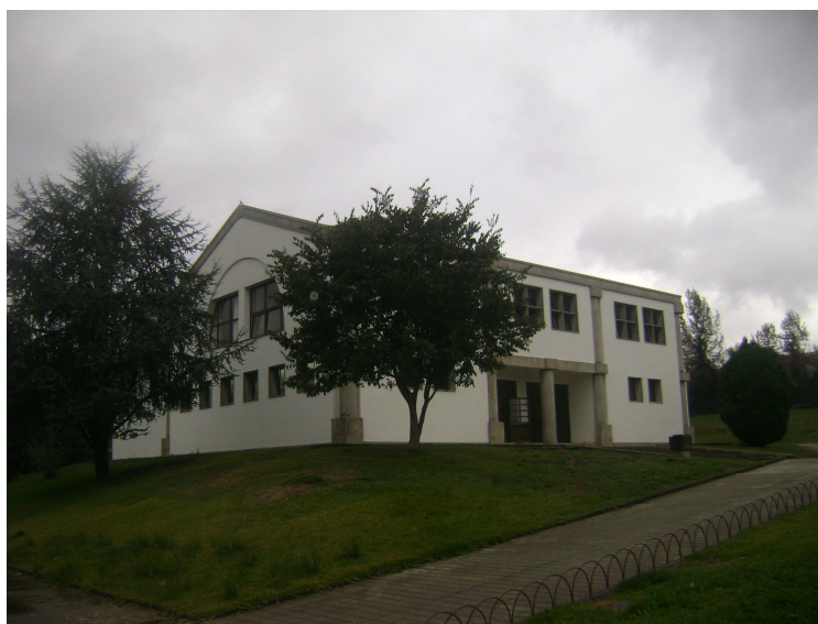
Figura 1- Pavilhão Gimnodesportivo da Escola EB2/3 de São Torcato
