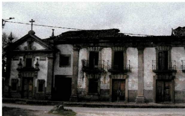
Fig. 7 - Casa da Ferreira de Faldejães
