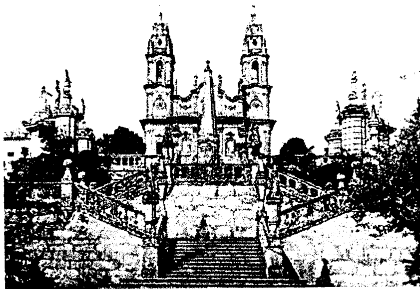
Figura 40 - Fase final da construção das torres e alteração do frontispício.
