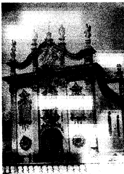
Figura 20 - Fachada da Igreja de Nossa Senhora dos Remédios de Lamego.
