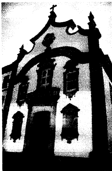
Figura 22 - Fachada da Igreja de S. Filipe de Nery (Viseu).
