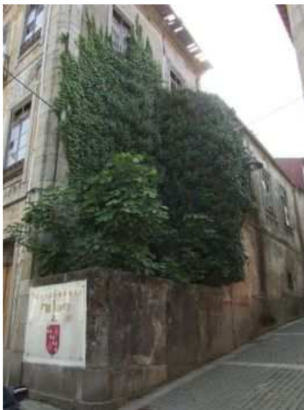
Vista parcial da rua de S. António das Travessas. Algures nesta fachada, os nºs 3 e 4...
