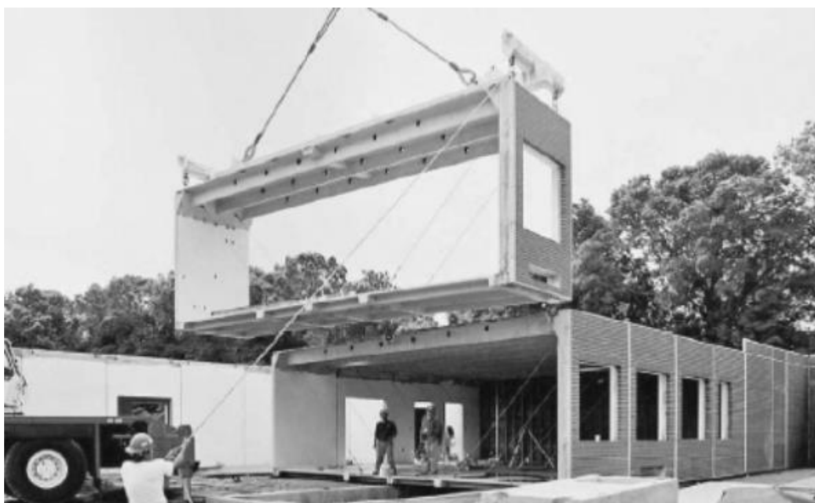
Figura 2.6 – Instalação de unidades modulares pré-fabricadas para uma escola.
