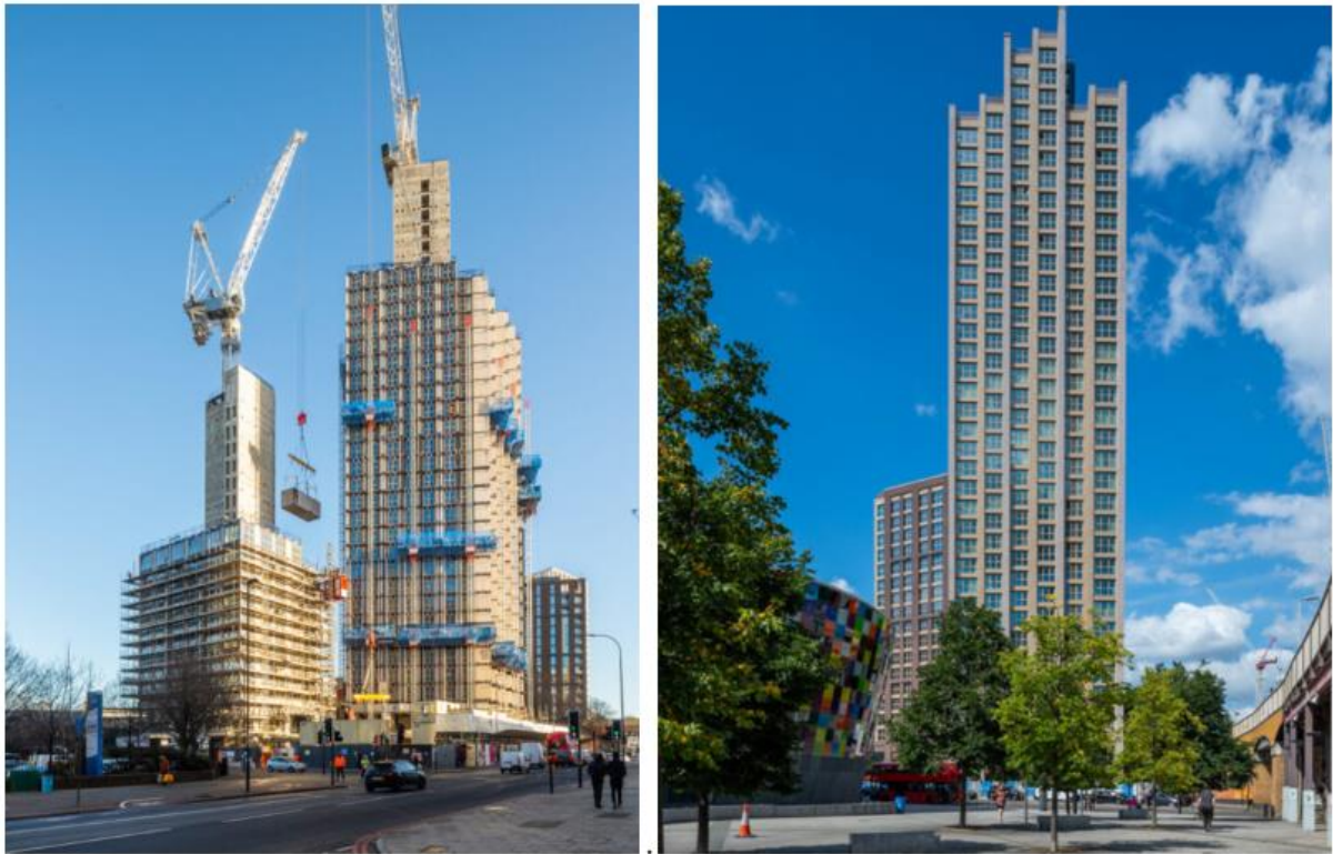
Fig. 2.3 - Lewisham Exchange em fase de construção, com os módulos de aço sendo instalados, e concluído.
