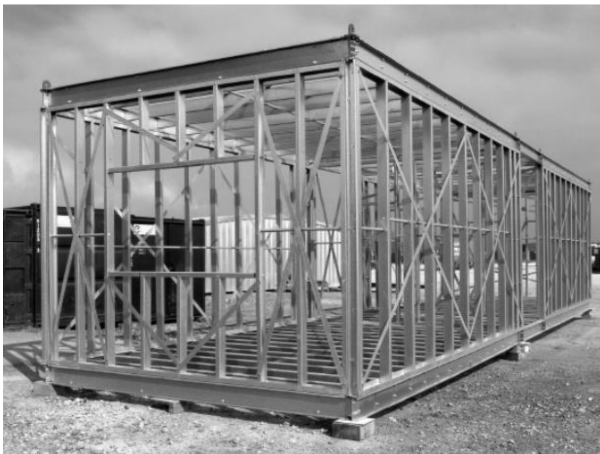
Fig. 2.4 - Módulos de aço com suporte de canto.
