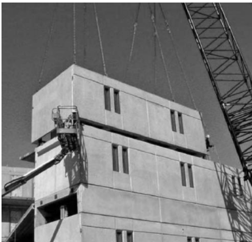
Figura 2.5 – Instalação de módulos de betão pré-fabricado em obra
