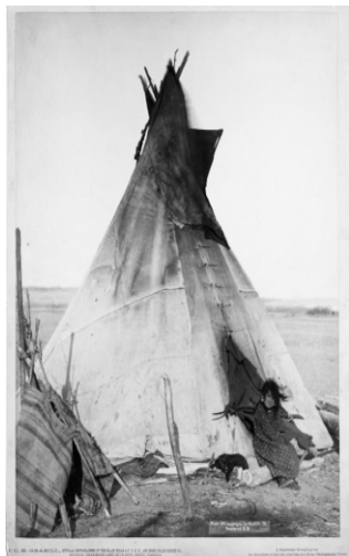
Fig. 3 Fotografia do Tipi onde é possível ver as duas aberturas no topo do cone que permitem extrair o fumo do fogo
