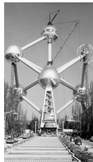
Fig. 13 Fotografia do Atomium durante o período de construção na Expo 58 em Bruxelas.
