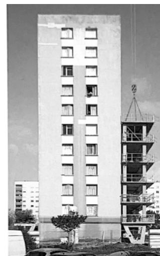
Fig. 76 Fotografia de um dos edifícios do complexo 530 unidades habitacionais em Bordeaux de Lacaton e Vassal durante a fase de construção em 2015
