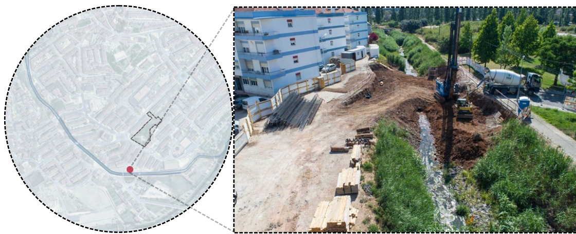
Figura 38 Localização da nova ponte entre a rua Dário Canas e a rua Vale do Forno (esquerda); Obra a decorrer (direita).
