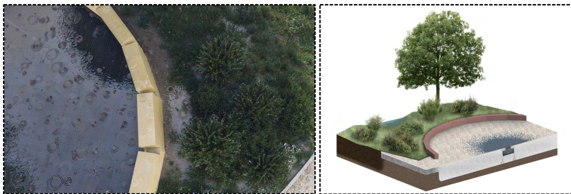
Figura 13 Vala de brita: Jardim Capitão Manuel Gomes Coelho, Odivelas (esquerda); Poço de brita: Jardim Capitão Manuel Gomes Coelho, Odivelas (direita).
