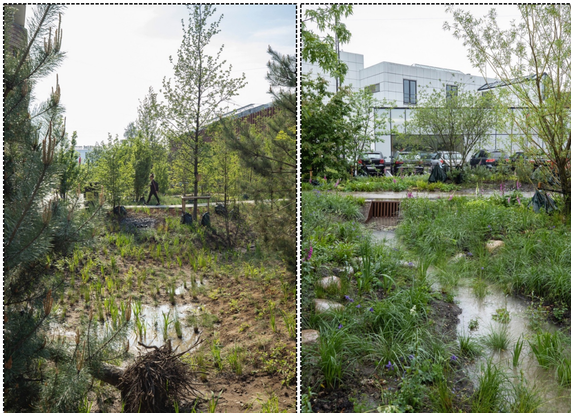
Figura 23 Soluções de biorretenção: Depressão (esquerda) e vala (direita).
