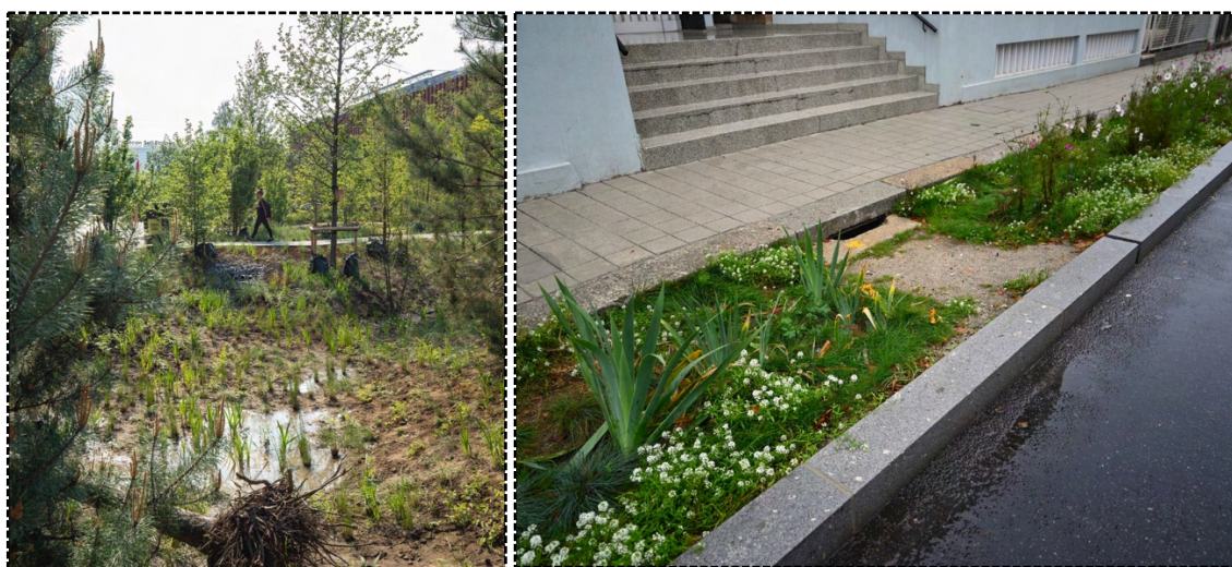
Figura 12 Depressão de biorretenção: Sankt Kjelds Plads, Copenhaga (esquerda); Jardim de chuva: Rua Santos Pousada, Porto (direita).
