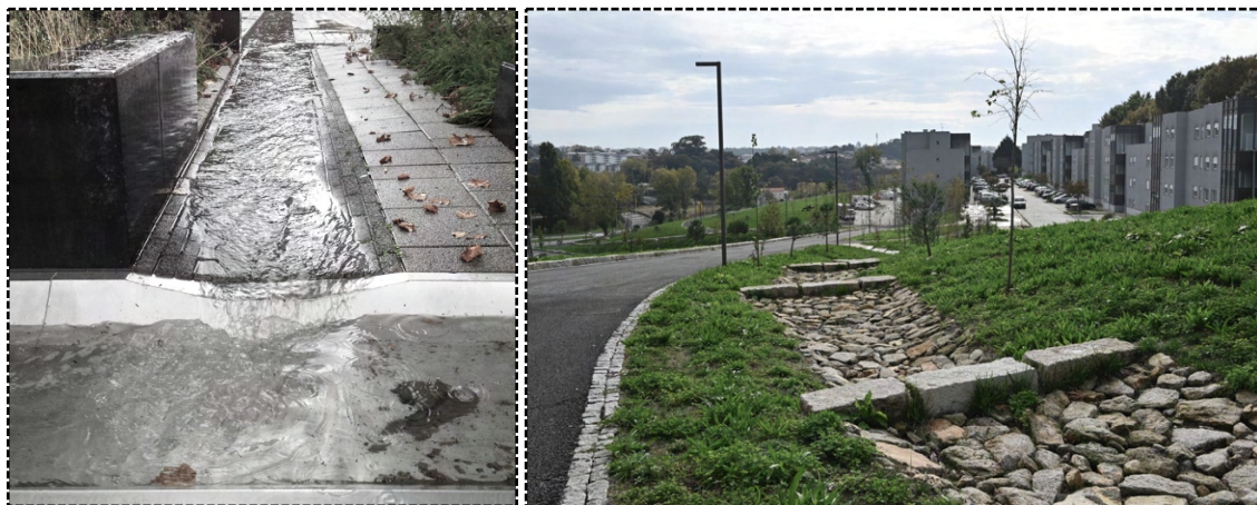
Figura 16 Canal de drenagem: Benthemplein, Roterdão (esquerda); Canal de escoamento (check dam): Parque da Alameda de Cartes, Porto (direita).
