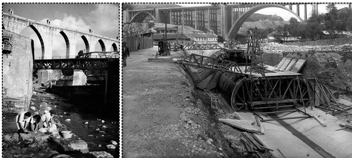
Figura 1 Lavagem de roupa na Ribeira de Alcântara, Lisboa (esquerda); Construção do Caneiro de Alcântara para cobrir o talvegue (direita).
