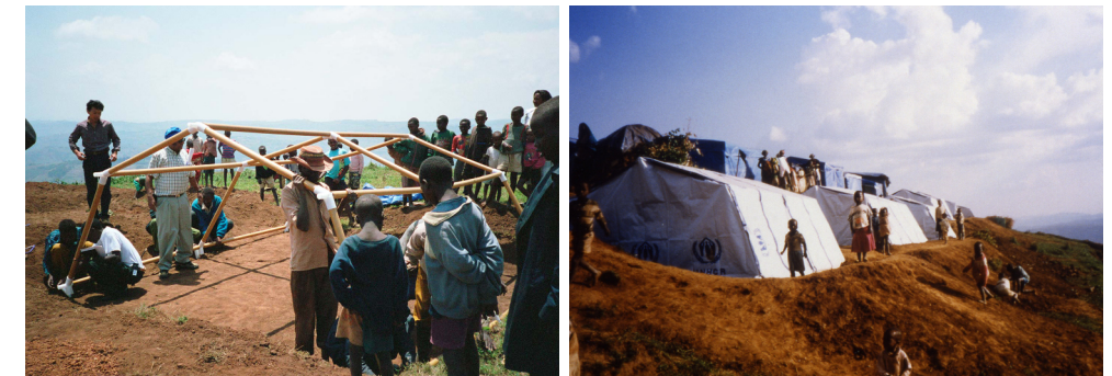
Figuras 109-110: Nos refúgios para as pessoas deslocadas pelo genocídio no Ruanda em 1994, Ban experimentou as estruturas feitas com tubos de cartão, um material com o qual o arquiteto é hoje fortemente associado.
