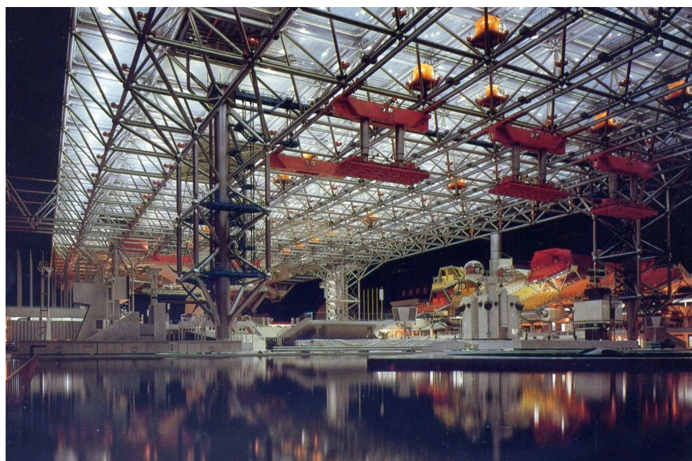
Figura 56: Big Roof de Tange que acolhia toda a Festival Plaza central à Expo, construída como uma experimentação de uma Space Frame a que várias exposições se podiam interligar facilmente.
