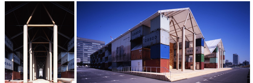
Figuras 114-115: Nomadic Museum em Tóquio. Shigeru Ban, 2007. Levando a flexibilidade espacial à escala global, a montagem modular permite que a estrutura seja desmontada e reconstruída em qualquer parte do mundo com acesso a contentores marítimos e tubos de cartão.
