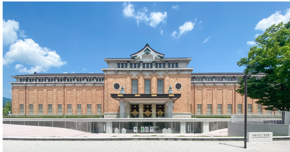
Figura 37: Museu Municipal de Arte de Quioto, um edifício prominente no estilo teikan, é caracterizado pela justaposição de uma estrutura principal de influência neoclássica ocidental com uma cobertura de telha em estilo tradicional japonês.
