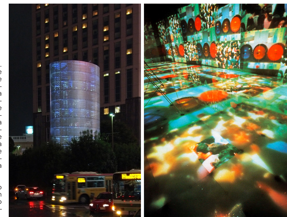
Figura 101: Tower of Winds . Toyo Ito, 1986. Trata-se de uma chaminé para chillers de um centro comercial e estacionamento. No entanto, a sua natureza funcional é camuflada pela aplicação de milhares de LEDs que respondem ao som e temperatura ambientes, brilhando por detrás de uma superfície de metal perfurado. A resposta da arquitetura ao ambiente torna-a mediadora de informação com quem percorre a cidade.
