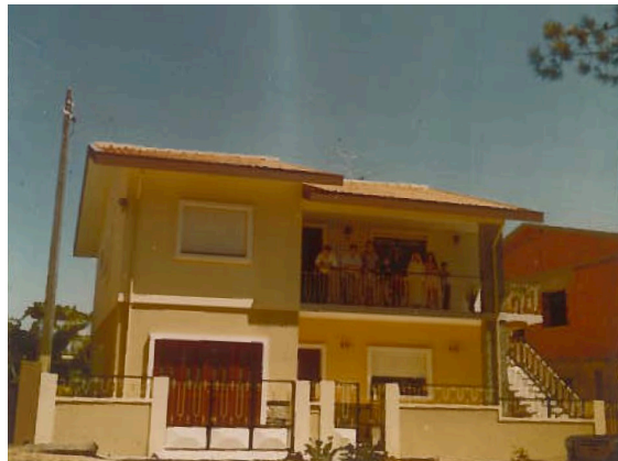
35- A casa concluída, 1974
