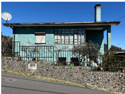
Fachada principal da casa voltada à Rua do Sol
