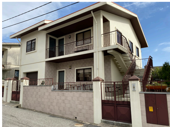
37- Estado atual da fachada da casa
