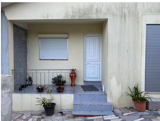
Entrada principal da casa
