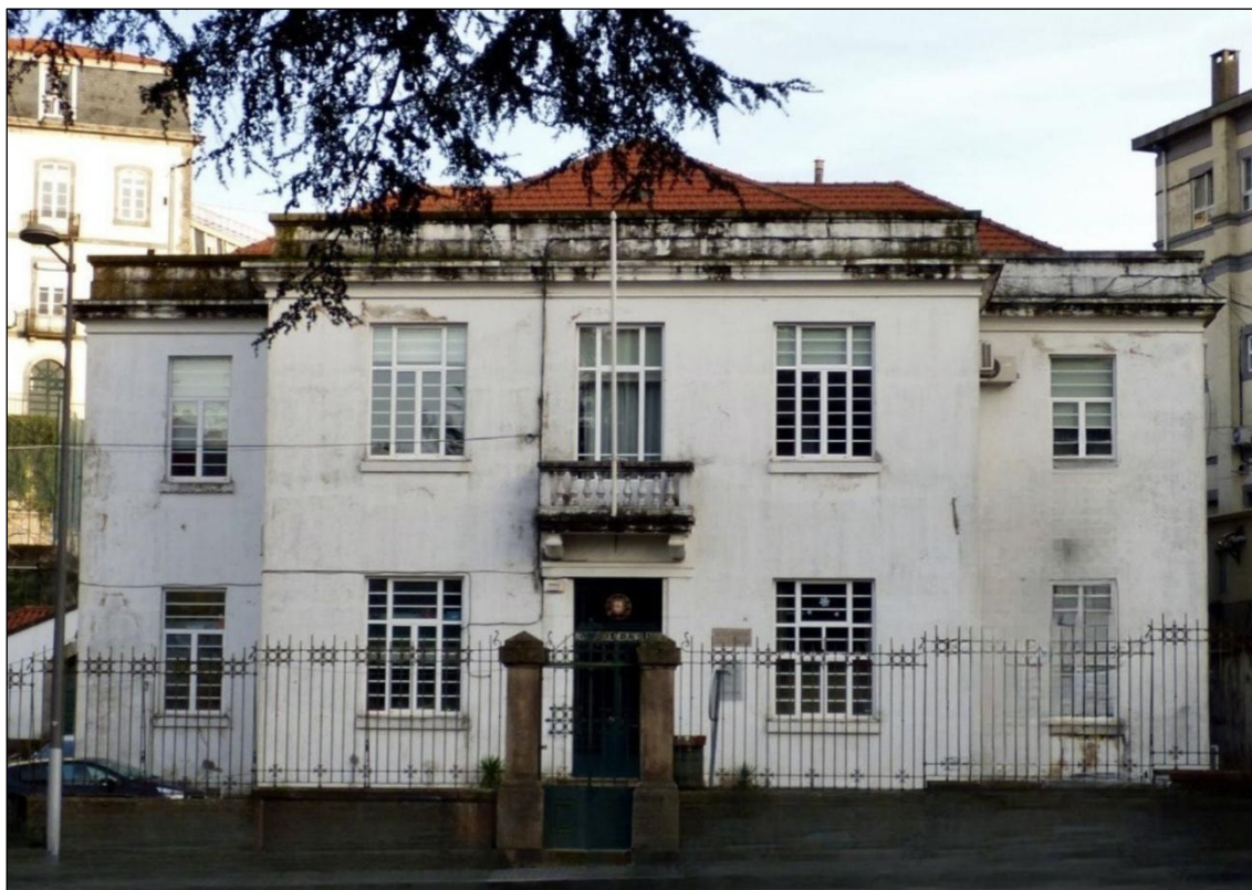
Figura 1 – Edifício do INMLCF-DN
