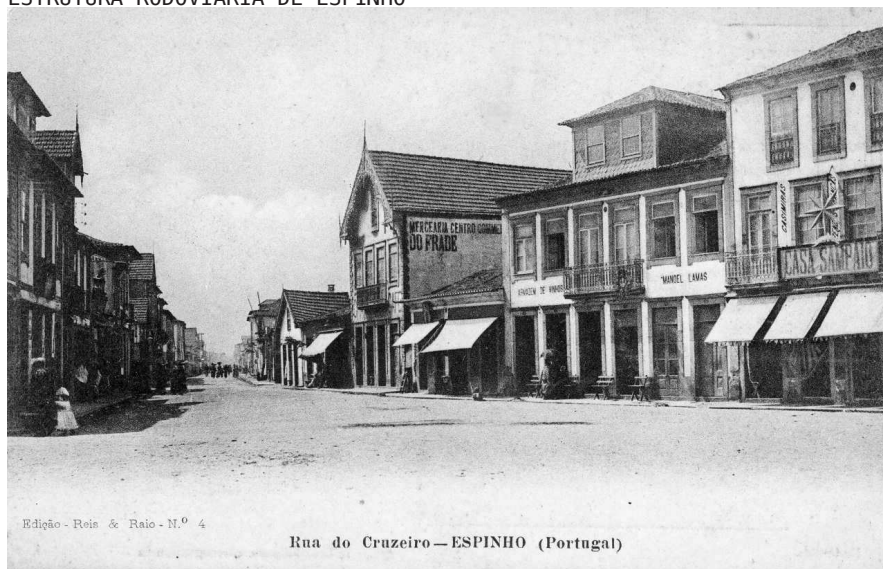
IMAGEM 6_ http://ww3.aeye.pt/avcultor/Avcultor/Postais4/Espinho/255_Espinho.jpg ESTRUTURA RODOVIÁRIA DE ESPINHO
