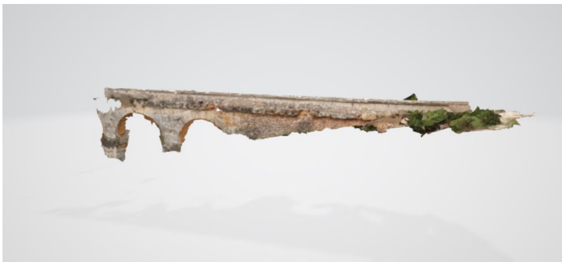
Anexo 24 – Aqueduto. Fonte: Sketchfab .
