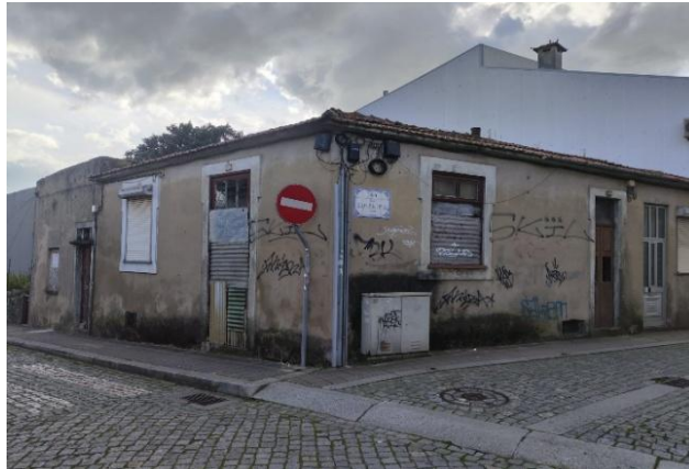
Figura 3 - Rua da Cidreira n.º 177
