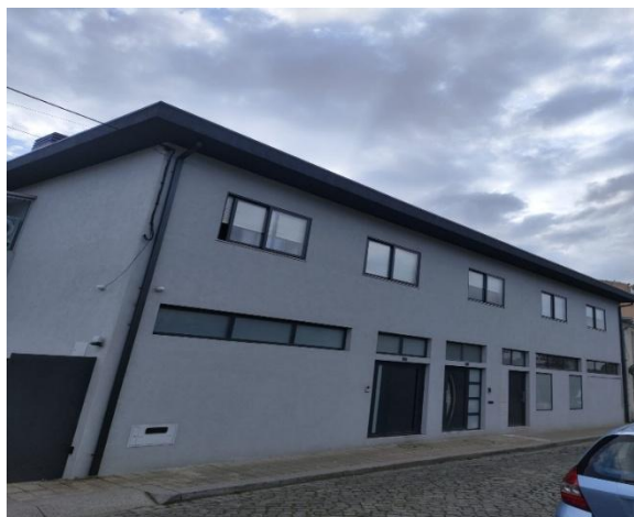
Figura 8 - Rua da Cidreira n.º 347 (moradia cinzenta)
