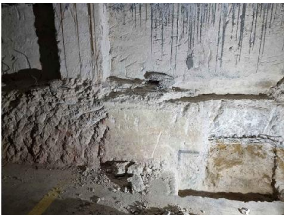
Figura 15 – Paredes de Contenção e sua fundação (Fonte: Relatório de inspeção, 2025)
