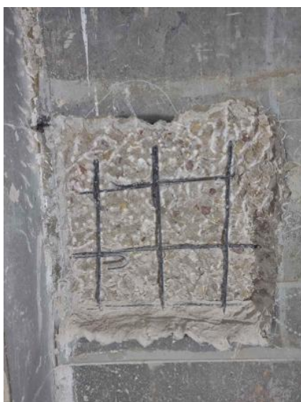
Figura 14 – Camada única de armadura com varões de Ø8/0,20, em paredes acima do solo (Fonte: Relatório de inspeção, 2025)
