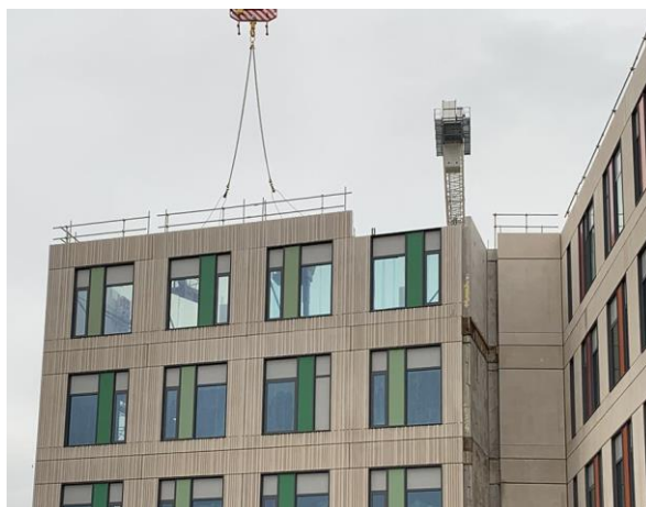
Figura 10 - CM tipo III: processo de construção do projeto híbrido The grange University Hospital
