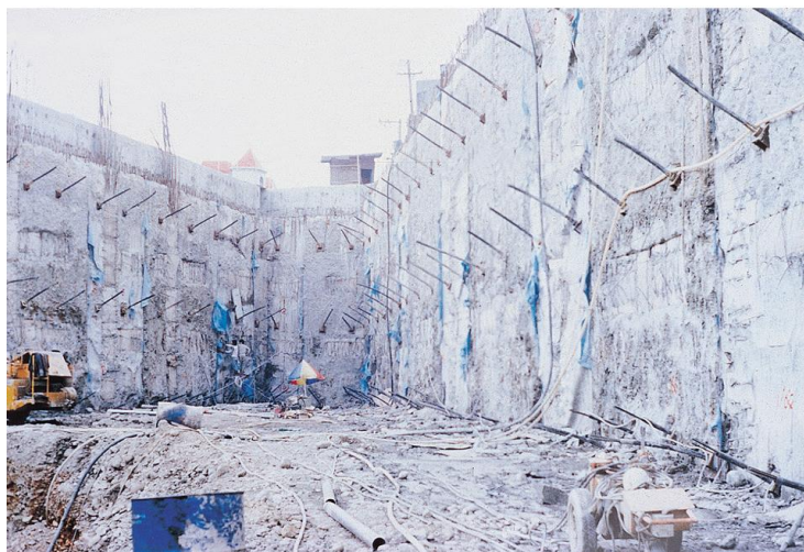
Figura 1 - Exemplo de uma contenção profunda ancorada (Ou, 2021)
