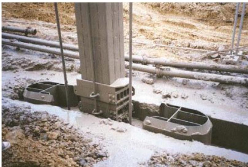
Figura 6 - Processo de escavação dos painéis entre os alinhamentos dos muros guia (Brito, 2001)
