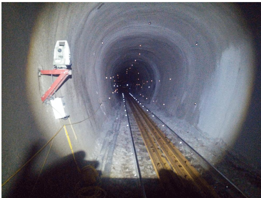
Figura 15 - Exemplo da instrumentação de um túnel com recurso a alvos topográficos (GEODATA, 2019)
