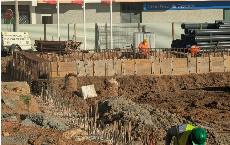
Figura 13 - Exemplo de saneamento de estacas e execução da viga de coroamento
