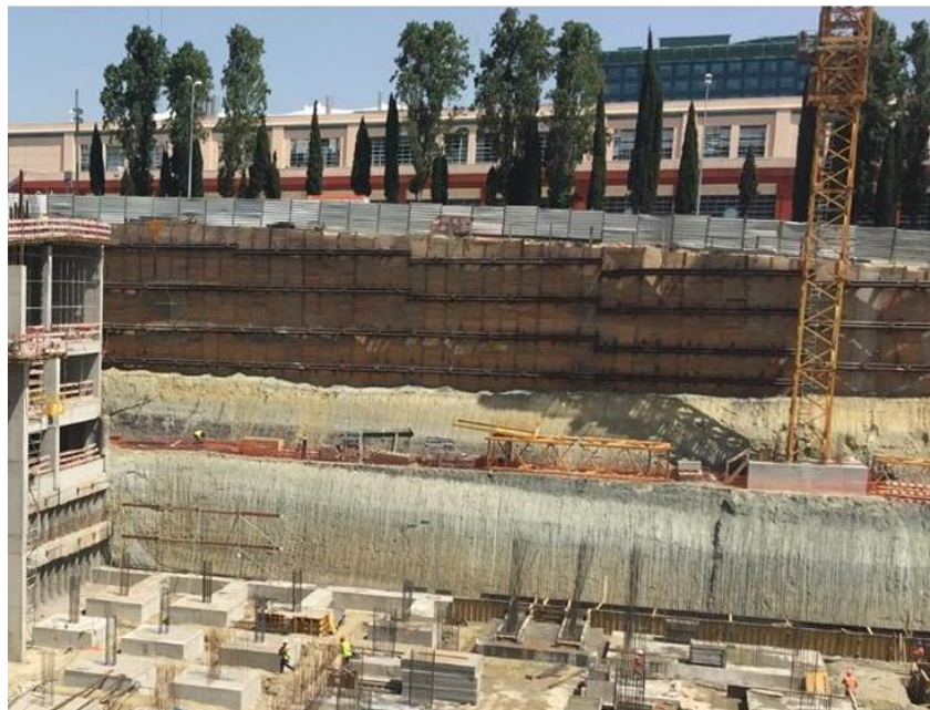
Figura 5 - Exemplo de uma cortina berlinense – solução King Post (Tomásio & Pinto, 2019)
