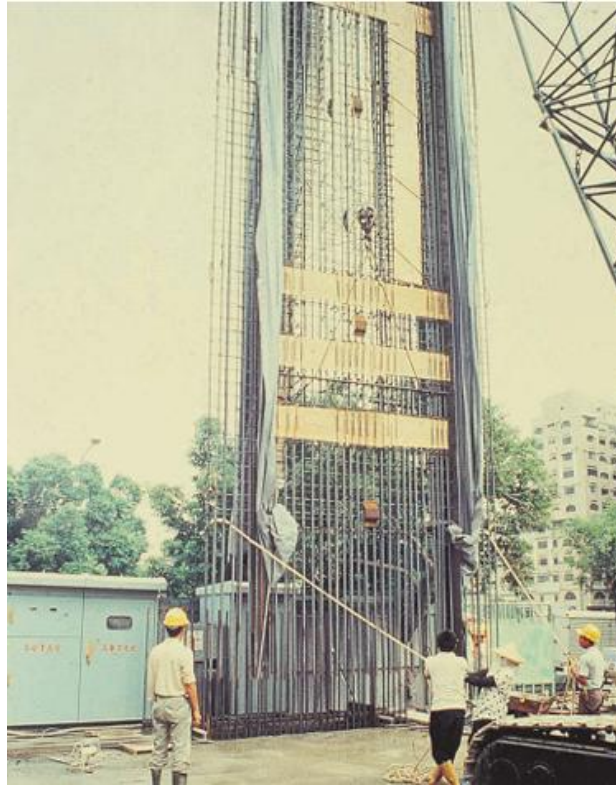
Figura 7 - Colocação das armaduras na trincheira (Ou, 2021)
