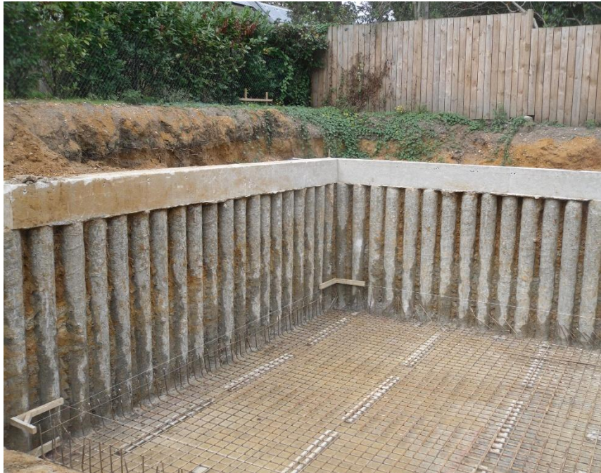
Figura 4 - Exemplo de uma cortina de estacas tangentes (Underpin & Makegood, 2026)
