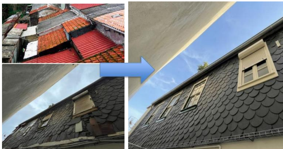
Figura 17 - Manutenção dos telhados
