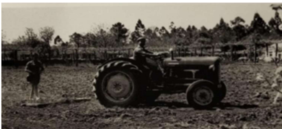
Figura 10 - Grade a ser puxada por um tractor. Pessoa em cima da grade de forma aumentar o seu peso, em Barcelos no ano de 1977. (Pereira, Brito, Baptista, & Pereira, Eds., 1996)
