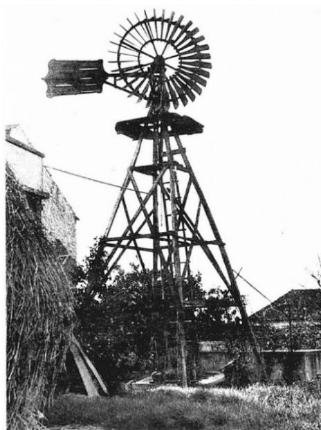
Figura 12 - Sistema eólico de elevação de água. (Dias & Galhano, 1986)
