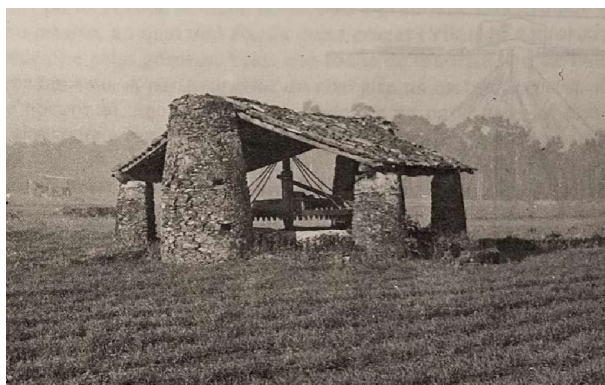
Figura 14 - Engenho de tirar água de buchas com telheiro em Válega. (Dias & Galhano 1986)
