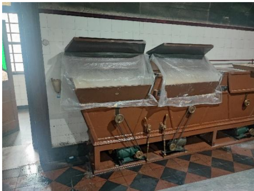
Figura 53 – Engenhos em funcionamento, protegidos por uma cobertura plástica para prevenir um possível derramamento de resíduos decorrentes de salpicos de massa no início do processo de batimento. (Imagem de autoria própria, fotografada a 5 de junho de 2025)
